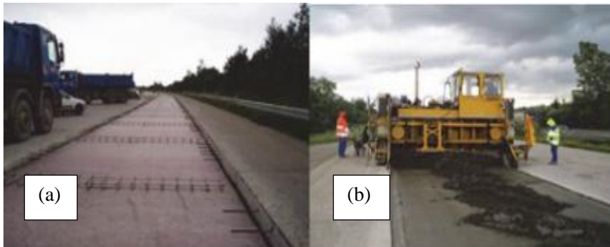
Resim 1.5 Şerit yenileme (a) hazırlık ve (b) uygulama (Benedetto and Pensa 2007).
