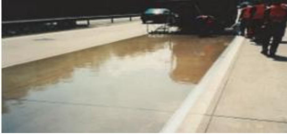
Resim 1.6 Makine ile reaktif reçine uygulaması(Benedetto and Pensa 2007).
