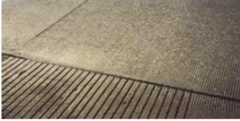
Resim 1.4 Kanallı frezeleme (Garcia vd. 2017).
