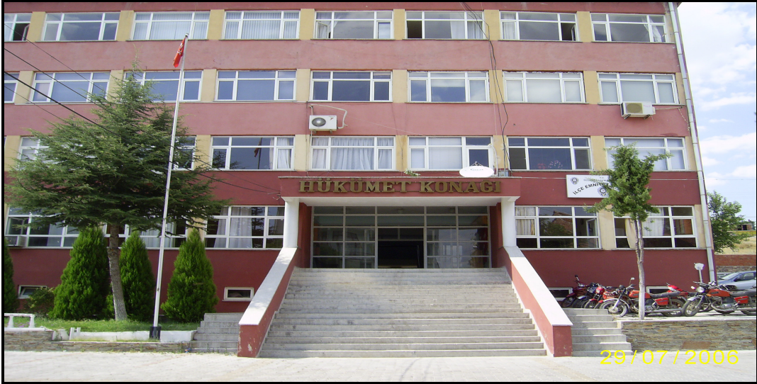
Fotoğraf 15. Selendi Yeni Hükümet Konağı (Kaymakamlık, Emniyet Amirliği, Müftülük, Milli Eğitim Müdürlüğü, Adliye, Maliye, Nüfus Müdürlüğü, Tapu Sicil Müdürlüğü), (2006).
