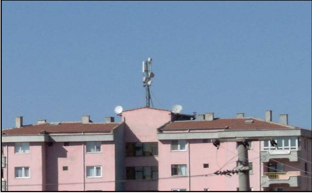
Şekil 76. Çatı Üstü Baz İstasyonları ve Elektrik Hatlarının Yarattığı Görsel Kirlilik
