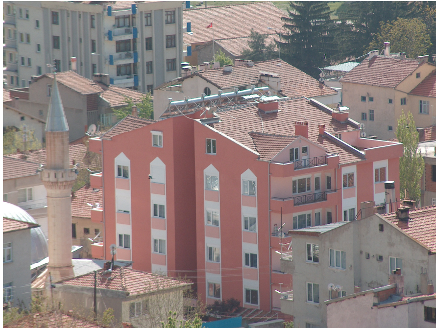
Foto 18: Şehirde Eski Yapıların Arasındaki Modern Konutlardan Bir Görünüm.
