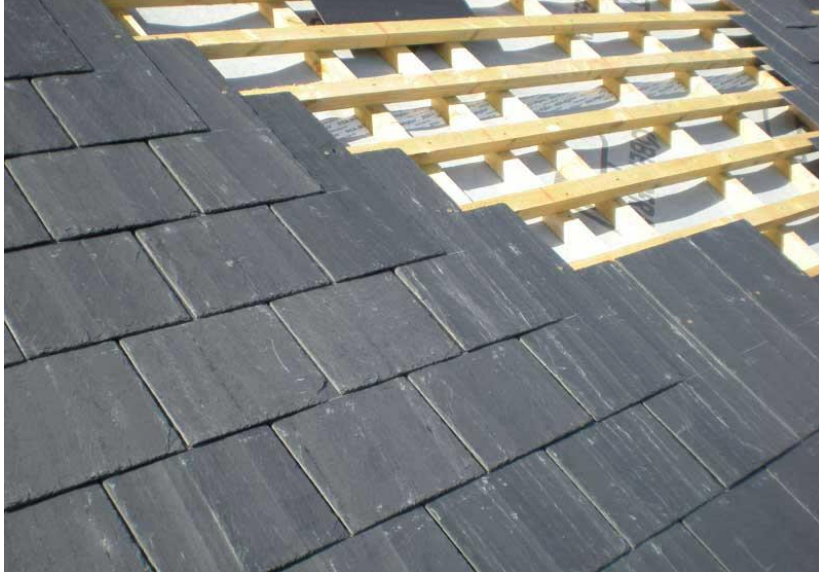
Resim 22. Sleytin çatı örtüsü olarak kullanımı
