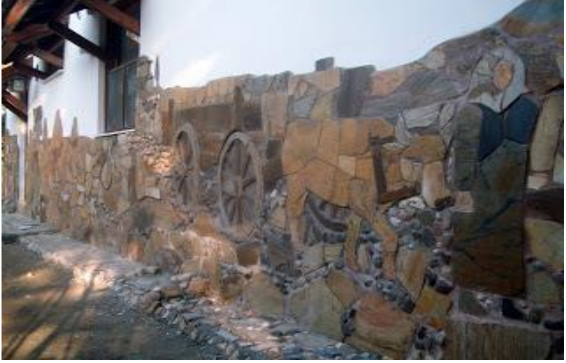
Resim 26. Kayrak taşı ile duvar uygulamaları
