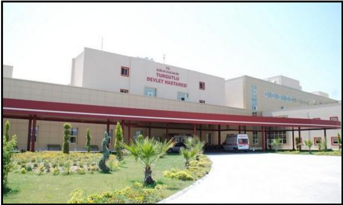
Foto 75. Yapımı Tamamlanan Yeni Devlet Hastanesinin Görünüşü.
