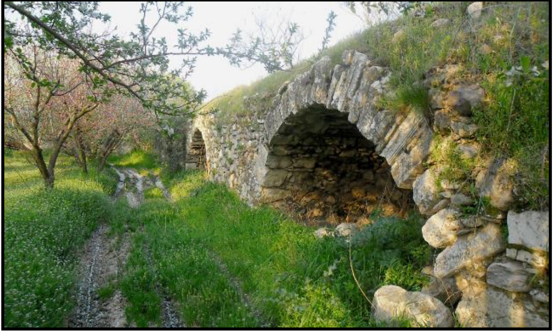
Foto 120. Gediz Nehrinin Eski Yatağı Üzerine Yapılan Kısmalı Köprüsünün Görünüşü.
