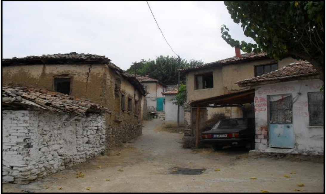
Foto 59. Aşağı Bozkır Köyünde İki Katlı Geleneksel Toprak Meskenin Görünüşü.
