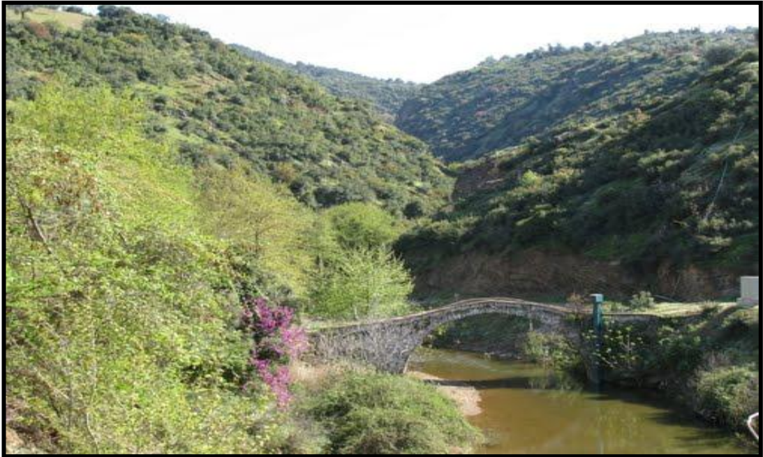
Foto 121. Çıkrıkçı Köprüsünün Görünüşü.
