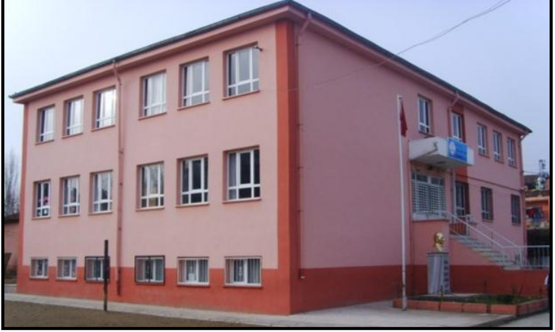
Foto 35. Çıkrıkçı Yaşar-Kazimet Aybars İlköğretim Okulunun Görünüşü.
