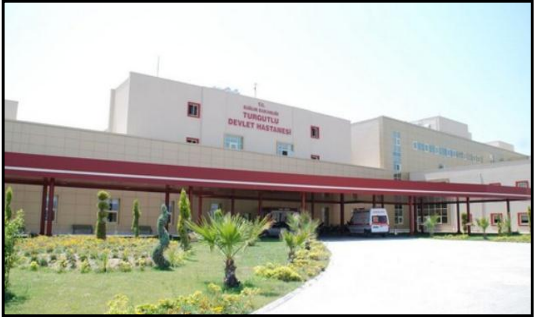
Foto 37. Turgutlu Devlet Hastanesi Yeni Binasından Bir Görünüş.
