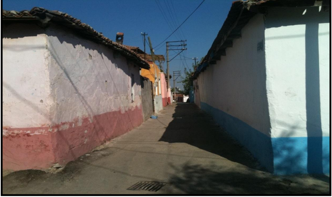
Foto 62. Albayrak Mahallesinde Dar Sokaklardan Oluşan Yerleşme Alanları.
