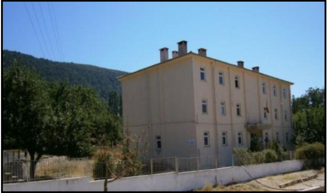
Foto 39. Dađmarmara 13 Nolu Aile Sađlık Merkezinin Görünüşü.
