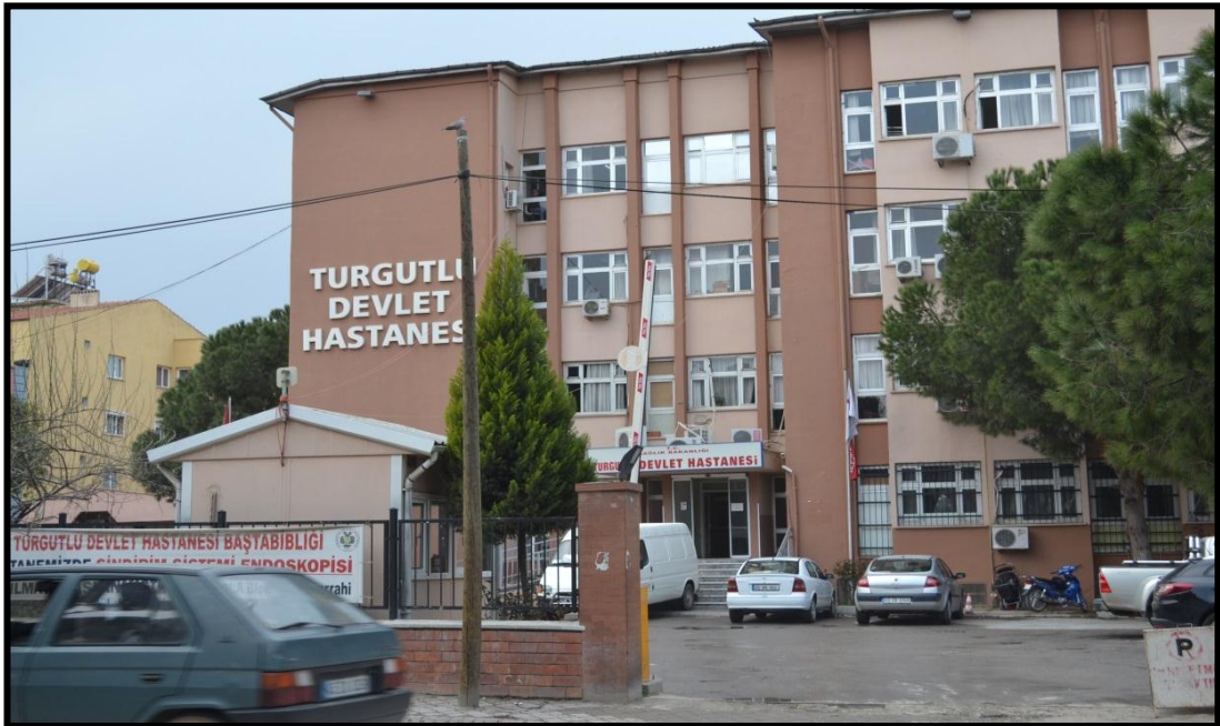
Foto 74. Turgutlu Devlet Hastanesinin Görünüşü.
