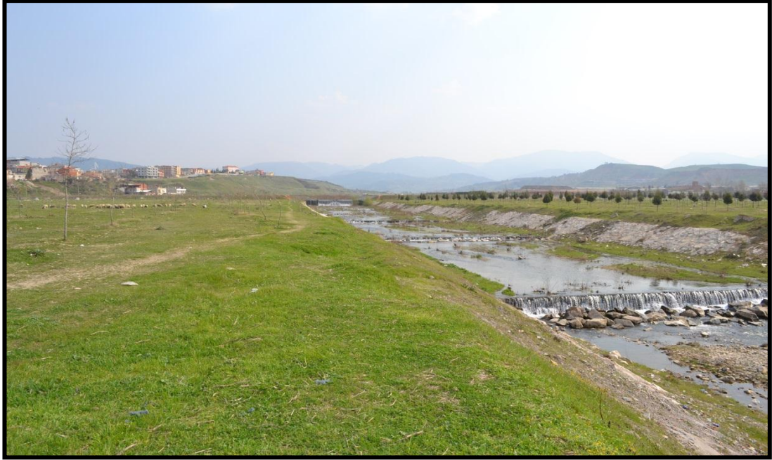
Foto 15. Kanal İçerisine Alınarak Turgutlu Ovasından Gediz Nehrine Karışan Irlamaz Deresinden Bir Görünüş.
