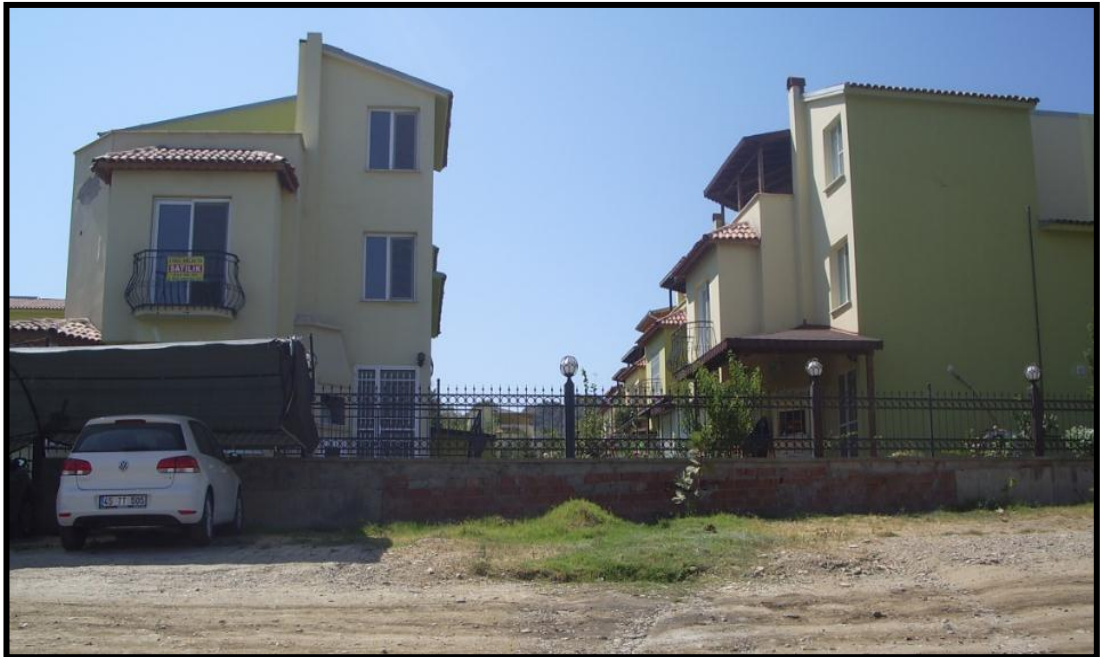
Foto 81. Ergenekon Mahallesinde Site İçerisindeki Konutlardan Bir Görünüş.
