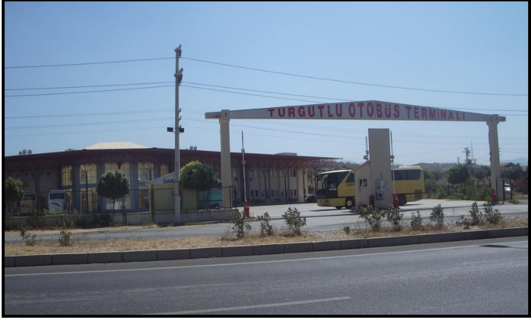
Foto 77. İzmir-Ankara (D-300) Karayolu Üzerinde Yer Alan Turgutlu Otobüs Terminalinin Görünüşü.
