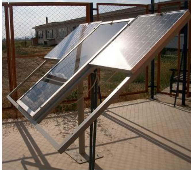
Resim 3.4 Üzerine panellerin yerlestirildiği sabit platform.
