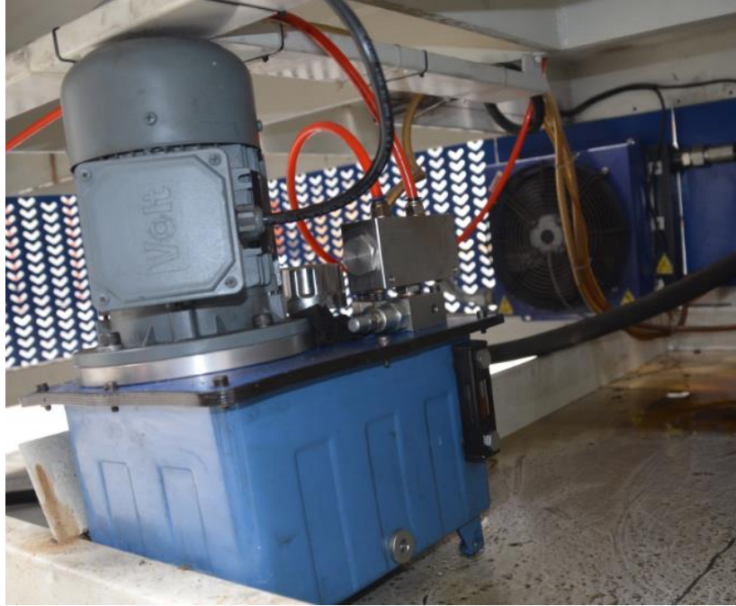
Şekil 3.22 Fanlı radyatör soğutma sistemi.
