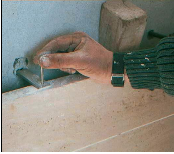
Şekil 2.5 Duvara taşıyıcı ve tutucu kenetlerin monte işlemi.
