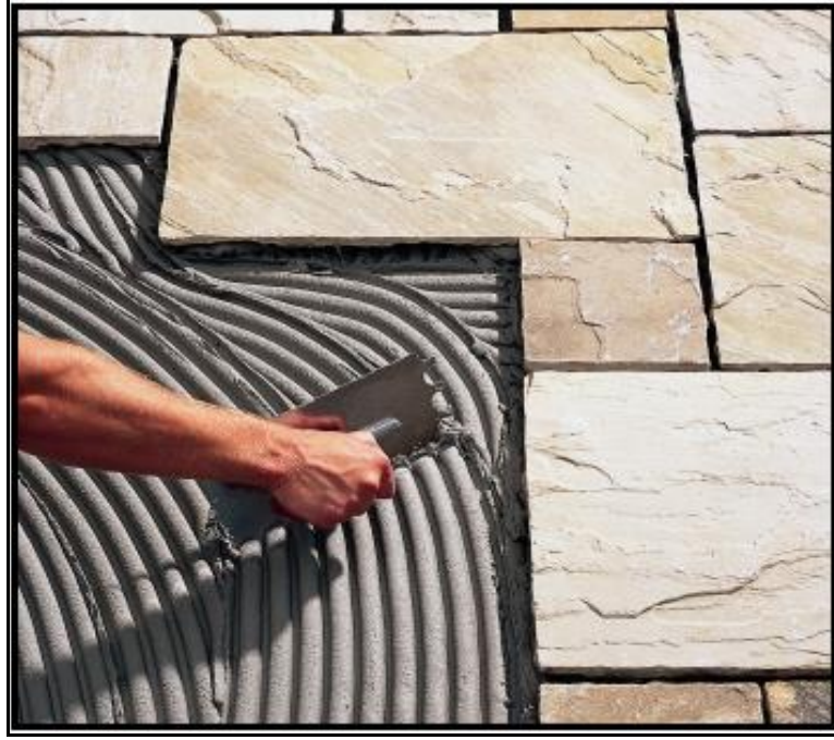
Şekil 2.2 Çimento harcı uygulaması (İnt.Kyn.1).
