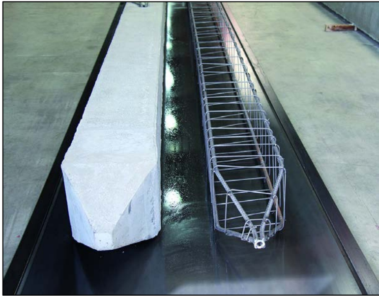
Resim 3.2 Çakma betonarme kazık.
