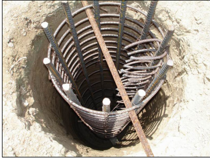
Resim 3.3 Yerde dökme betonarme çakma kazık.
