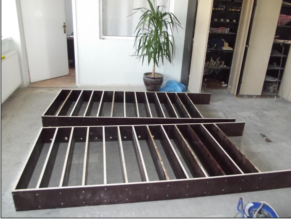
Resim 3.3 Kiriş numunelerinin için hazırlanan kalıp sisteminin görünüşü
