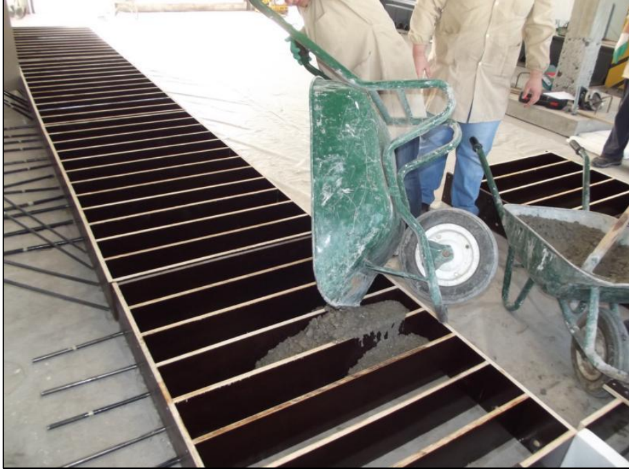
Resim 3.4 Kiriş parçalarının beton dökümü
