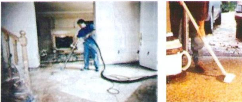
Şekil 3. Kirlenmiş yüzeylerin vakumla temizlenmesi.
