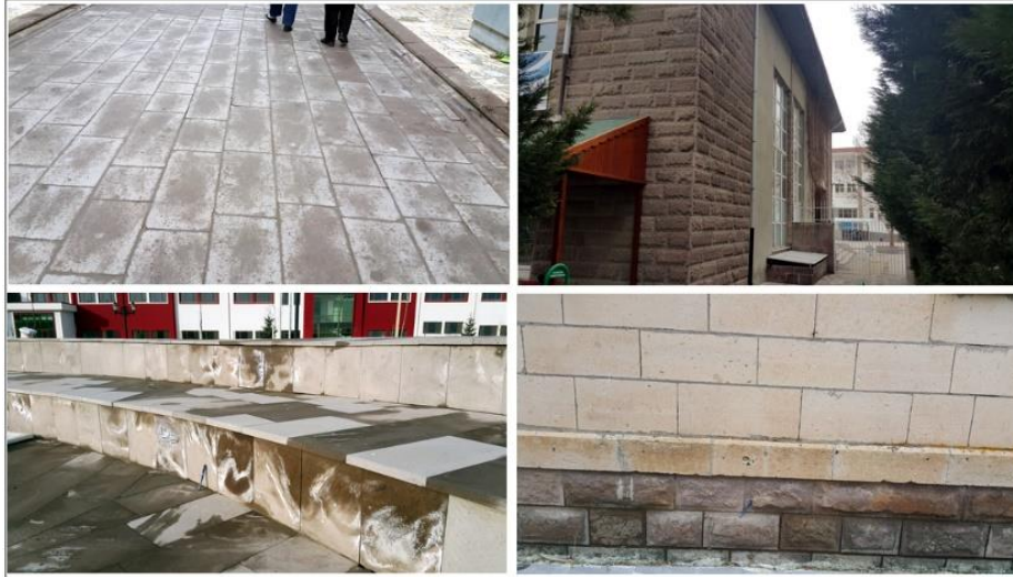
Şekil 1. Afyonkarahisar yöresinde andezitlerin değişik amaçlı kullanımı ve tuz kristallerine bağlı ayrışmaların görünümü
