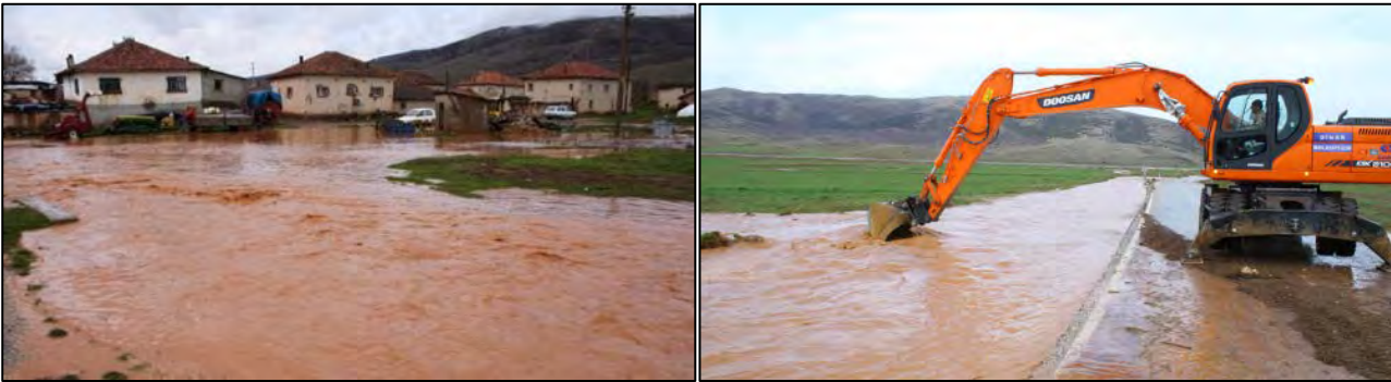
Foto 10 ve 11: 28 Mart 2015 Çağlayan deresi taşkının sırasında sel sularının yerleşim yerlerini ve Dombayovası'nın bir bölümünü basması sırasında iş makineleri ile kanal temizleme çalışmaları (Fotoğraf: Dinar belediyesi 2015' den).
