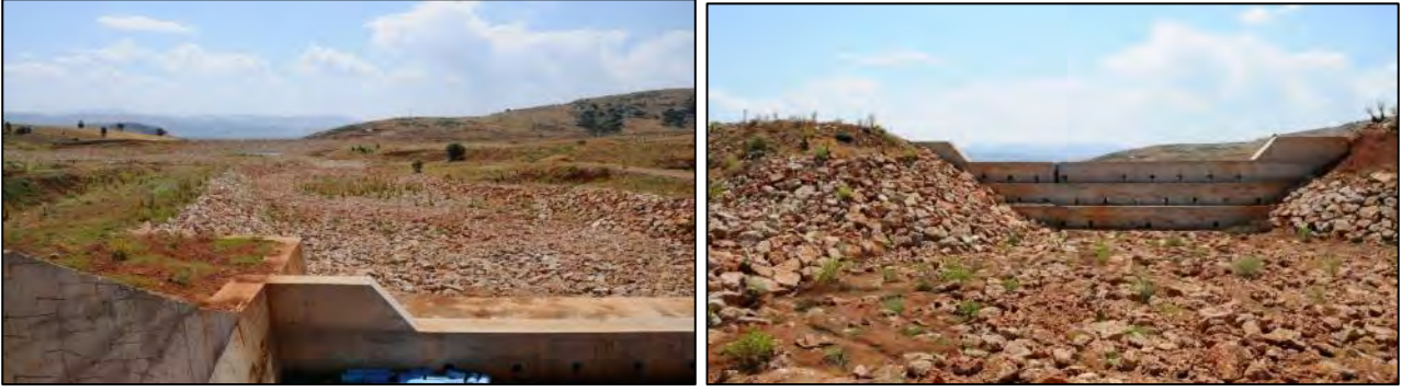
Foto 8 ve 9 : Gölet gerisinde yaklaşık 500 m sonra yeni bir betonarme set yapılmıştır. 18 Temmuz 2017 de bu set ve gerisinde su bulunamamıştır. Ana gölet setti gerisinde inşa edilen ikinci betonarme set ve fazla suları tahliye edecek su kanalı.
