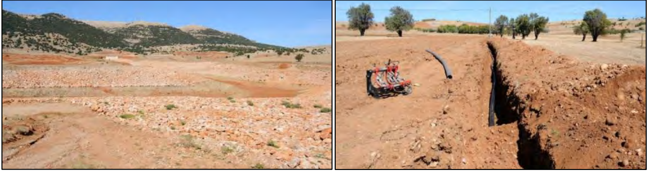
Foto 2: 23 Eylül 2016 gölet gövdesi gerisinde su depolama alanı, taban ve baraj gövdesinin killerle suyu geçirmemesi sağlanmış ve gerisinde yamaç stabilizasyonu için kaya blokları döşenmiştir.
