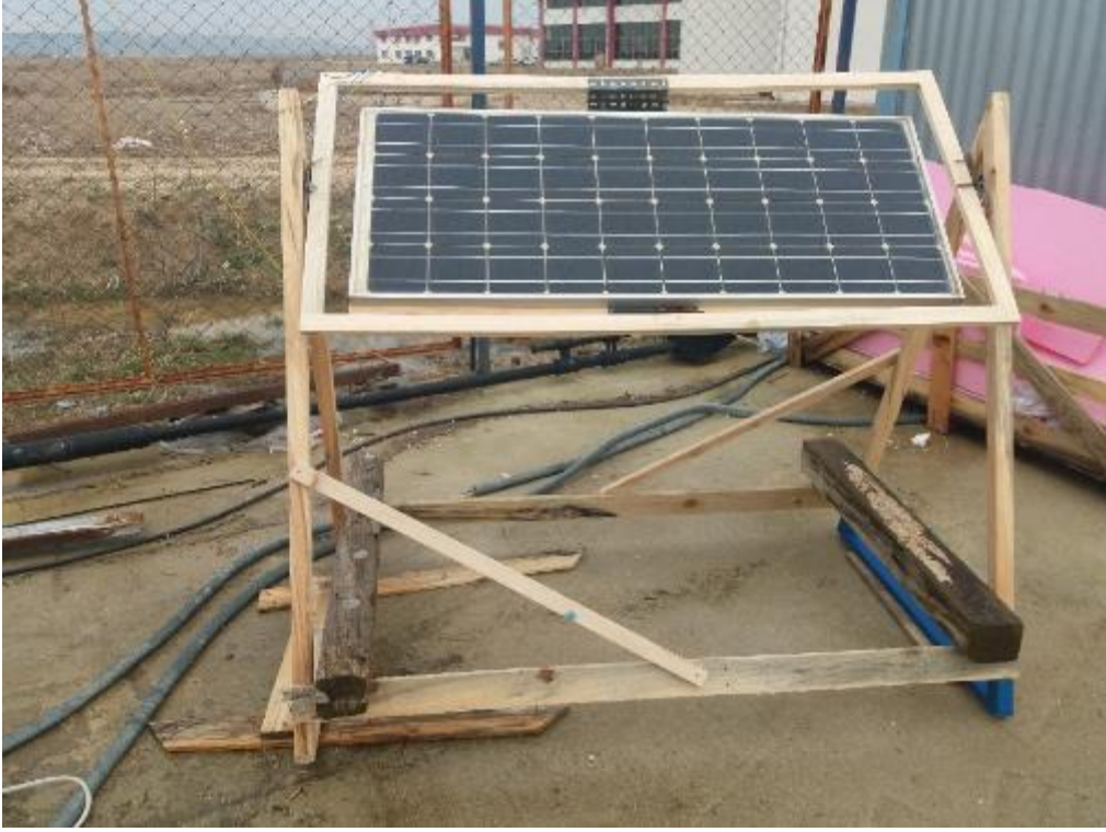
Resim 3.7 Panelin ahşap çerçeveye montajı.
