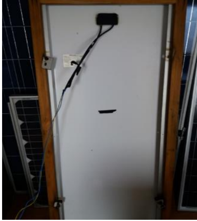
Resim 3.4 Panelin ahşap iç çerçeveye montajı.
