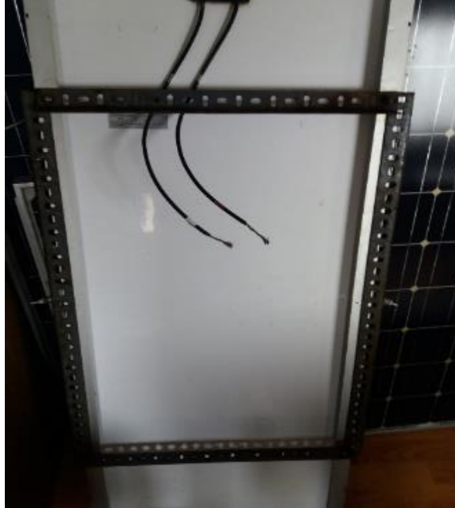
Resim 3.5 Panelin çelik iç çerçeveye montajı.
