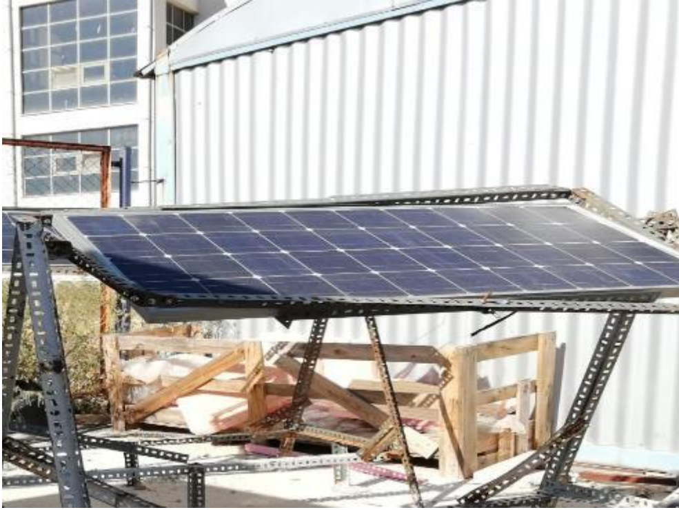
Resim 3.8 Panelin çelik çerçeveye montajı.
