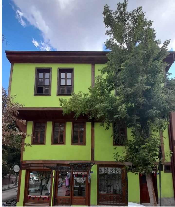
Şekil 40. Derneğin binası ve ikinci giriş kısmı.
