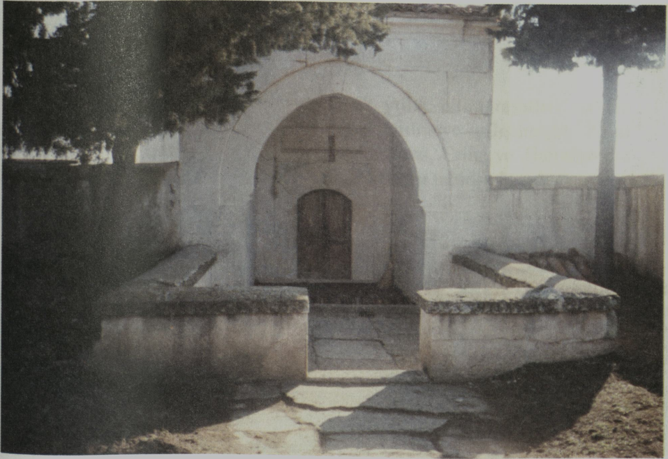
Resim-4 Türbe Kapısı
