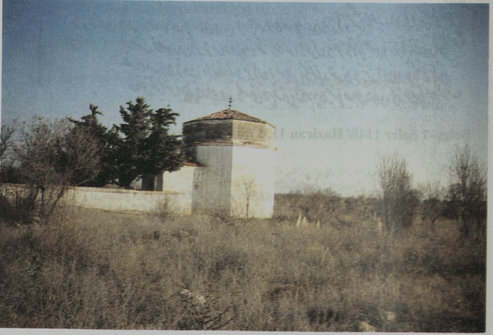
Resim-1 Hacim Sultan Türbesi
