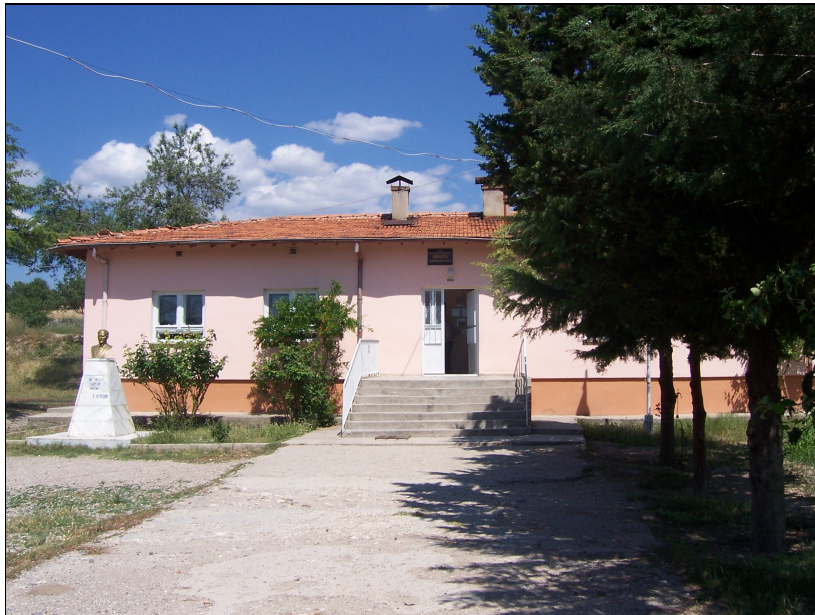
Fotoğraf 12. Mesudiye Köyü İlköğretim Okulu'nun Ön Cephesinden Bir Görünüm.
