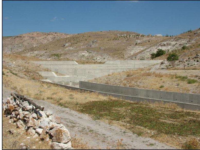
Foto 14: Dipevler Kuzeyi Sedimentasyon Taşımını Engellemek Amacıyla DSİ Tarafından Yapılan Geciktirme Terası Ve Setler.
