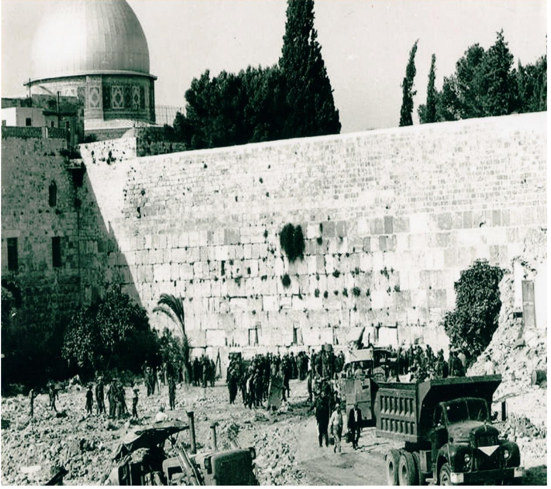
Resim 3: 1967 yılındaki Arap-İsrail savaşından sonra İsrail kuvvetleri Meğâribe mahallesini yıkma işlemini yerine getirmiştir. Bu kare yıkımın gerçekleşmesinden sonraki molozların temizliği esnasında çekilmiştir.
