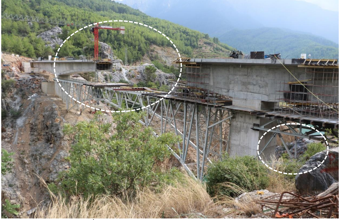
Foto 250. Işıктаşı Sırtı İle Karalharmanı Tepe'nin Kristalize Kireçtaşlarından Oluşan Alt Yamaçları Üzerinde Yapılan Akköprü İnşası. Fotoğrafta da görüldüğü üzere akarsuyun iki yamacını birleştirmek amacıyla yapılan yol inşası sırasında yamaçlarda gelişmiş göstermiş lapyta oluşumları zarar görmüştür.
