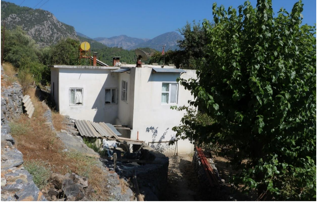
Foto 224. Ahmetgediği Tepe Yamaçlarına Kurulmuş Beledan Mahallesi'ne Ait Yerleşme (465 m). Sahanın ikliminden dolayı çatı düz olup yaz aylarında kışlık kurutmalıklar yapılarak değerlendirilmektedir. Beledan Mahallesi, fay dikliğinin altında çöken blok üzerinde yer almaktadır. Yerleşim alanında şist, gnays gibi geçirimsiz kayalar ile kristalize kireçtaşları yakın mesafeli olarak gelişim göstermiş olup söz konusu kayalar sık sık gözlenmiştir.
