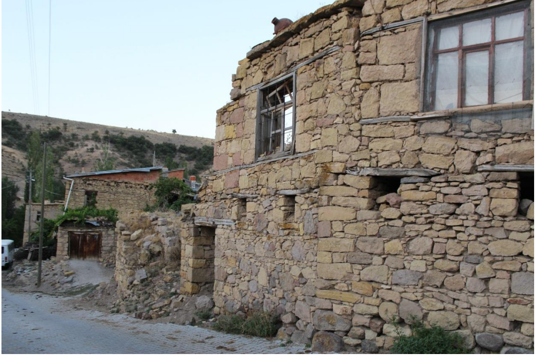
Foto 9. Taş Malzemenin Kullanıldığı Mesken: Konya Sadıklar Köyü
