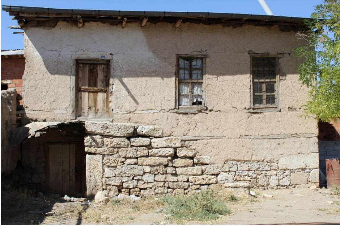
Foto 10. Taş ve Kerpiç Malzemenin Beraber Kullanıldığı Mesken: Konya Üçkilise (Orhaniye) Köyü
