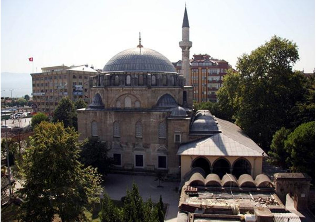
EK 6: Pertev Mehmet Paşa (Yeni Cuma) Cami 625 , Karabaş Mahallesi, İzmit Merkez.
