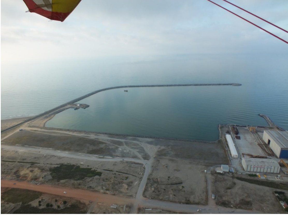
Resim 3.1 Karasu Limanının Havadan Çekilmiş Fotoğrafı.
