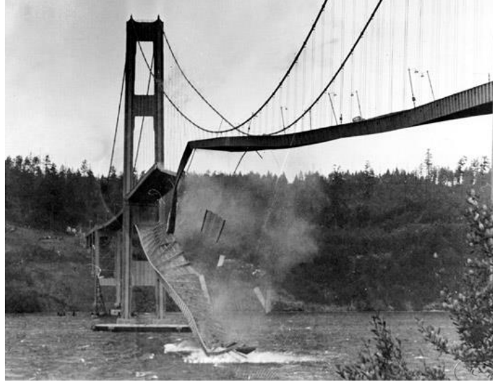
Şekil 3.16 Tacoma köprüsünün yıkılması (İnt. Kyn. 27).
