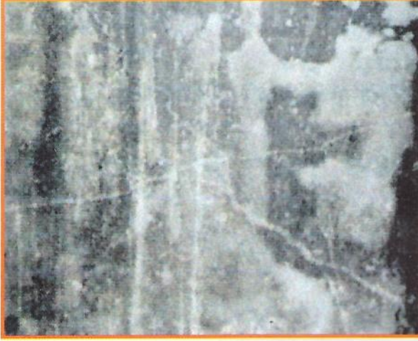
Şekil 4. Mermer yüzeyinde çiçeklenmenin oluşumu
