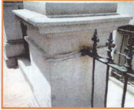
Şekil 2. Mermer yüzeylerde metallerin paslanması sonucu oluşan pas lekeleri (Mack, FAIA and Grimmer, 2000)
