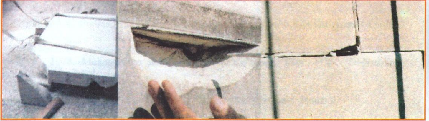
Şekil 7. Mermerlerde parça kopması şeklinde görülen parçalanmalar
