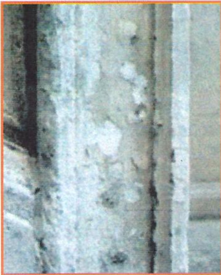
Şekil 5. Mermerlerde rutubetten kaynaklanan kabuklanma ve pul pul dökülme şeklinde ayrışma (Mack, FAIA and Grimmer, 2000)
