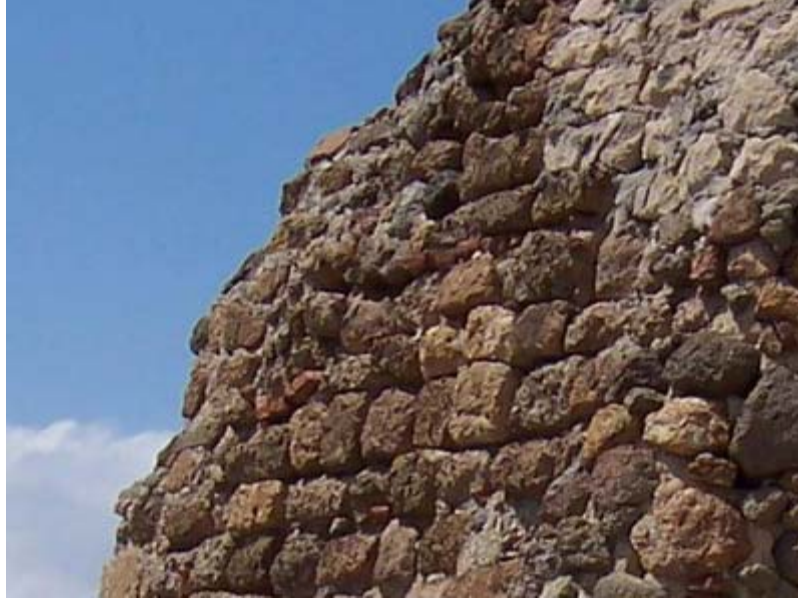
Şekil 5 Moloz taş duvar yapımında kullanılan traki-andezit ve andezitlerden detay.
