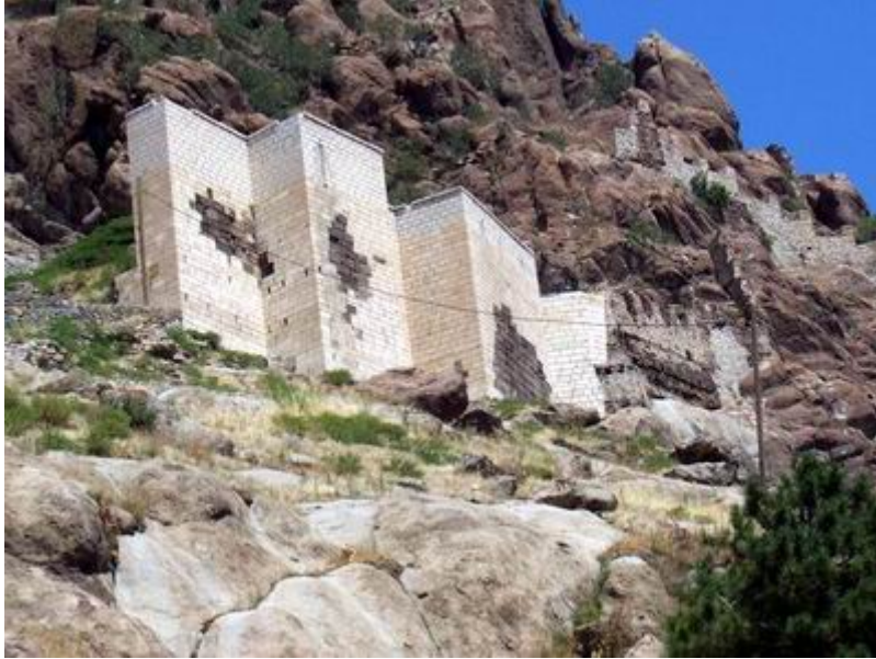
Şekil 9 Orta surlarda yapılan restorasyon çalışmalarında kullanılan tüflerin görünümü.
