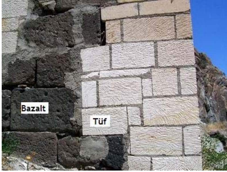
Şekil 4 Orijinal sur duvarında kullanılan siyah renkli bazaltlar ve restorasyonda kullanılan beyaz renkli tüflerin görünüşü.
