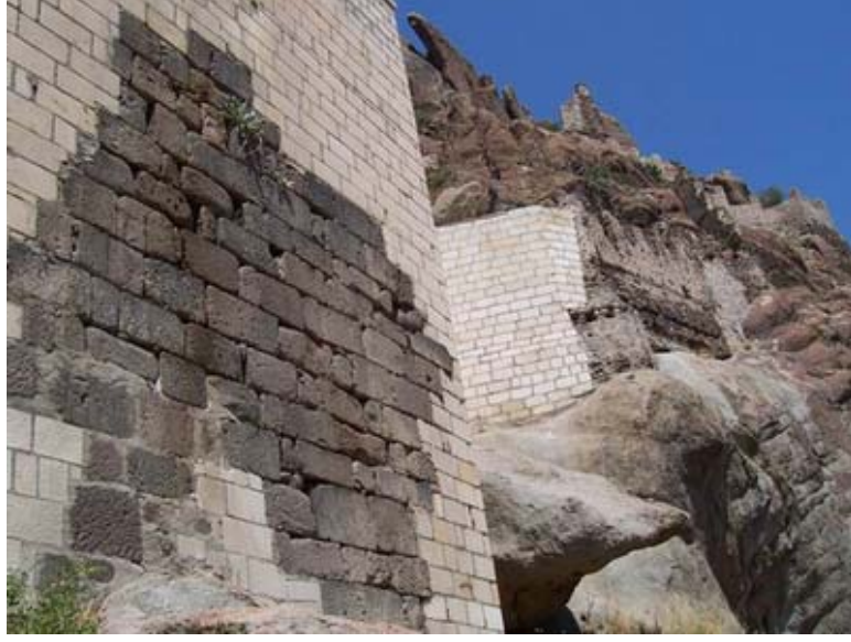
Şekil 2 Orta surlarda orijinal sur duvarları ve restorasyon çalışmalarından bir görünüş.
