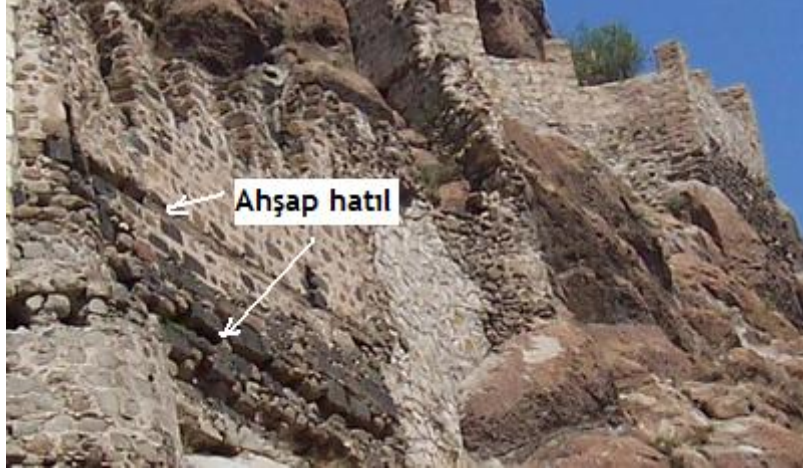
Şekil 6 Orijinal sur duvarları yapım tekniği.
