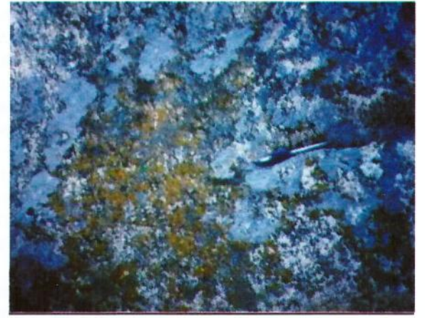
Şekil 6. Doğal taş yüzeyinde biyolojik etkenler sonucu ayrışma.
