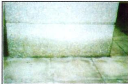
Şekil 7. Mermer ve doğal taşların rutubetlenmeden dolayı bozulması (Anon (b) ve (c), 2001).
