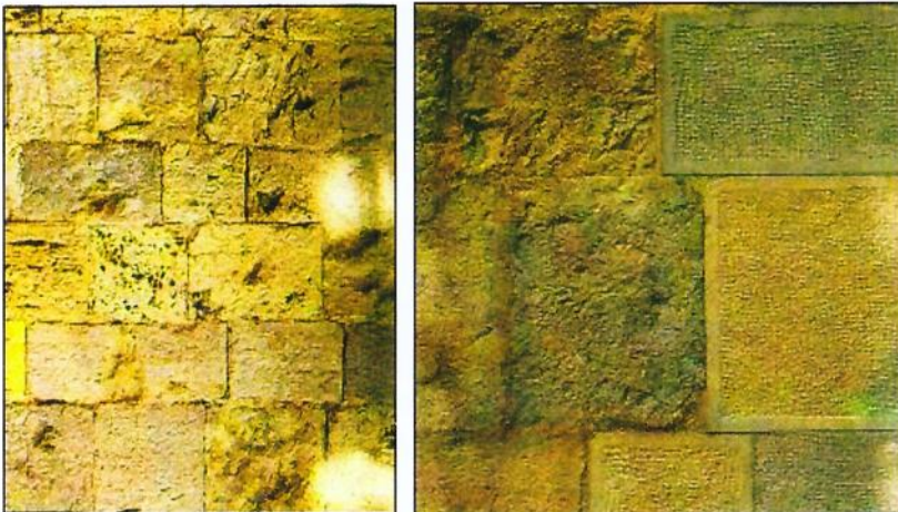
Şekil 1. Doğal yapı taşlarında yanyana kullanılan farklı taşlarda görülen ayrışma (Cadu-Narquet, 1994).
