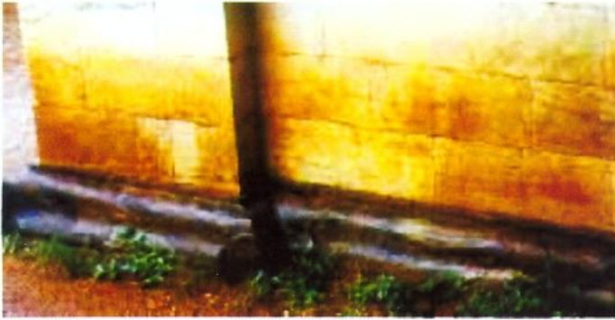
Şekil 7. Mermer ve doğal taşların rutubetlenmeden dolayı bozulması (Anon (b) ve (c), 2001).
