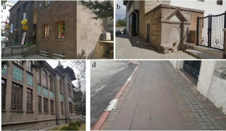
Şekil 1. İncehisar andezitinin yapı taşı olarak kullanımına örnekler: (a) Afyon PTT binası (1940), (b) Cürcani (Fakihpaşa) Camii çeşmesi (1827), (c) Afyon Lisesi (1894), (d) Afyonda bir kaldırım.
