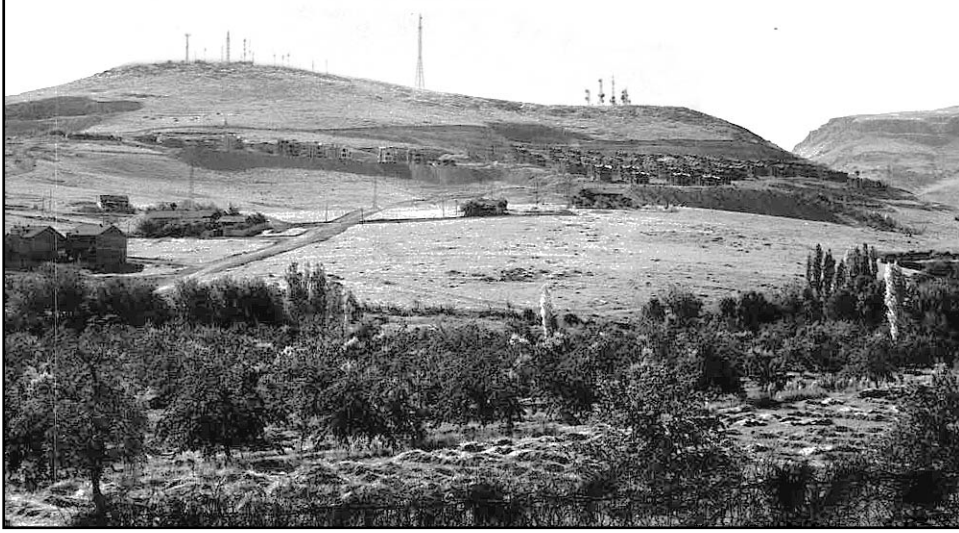
Foto 5: Yıkıkhane tepesi batı yamacında kiltaşından oluşan yamaç üstteki kalker kontağa (1) kadar tesviye edilmiş, yamaç eğimine dik yönde yol ve konutlar yapılmıştır. Böylece yamacın doğal dengesi daha da bozulmuş zeminde kayma, çökme ve çarpılmalar meydana gelmiştir.
