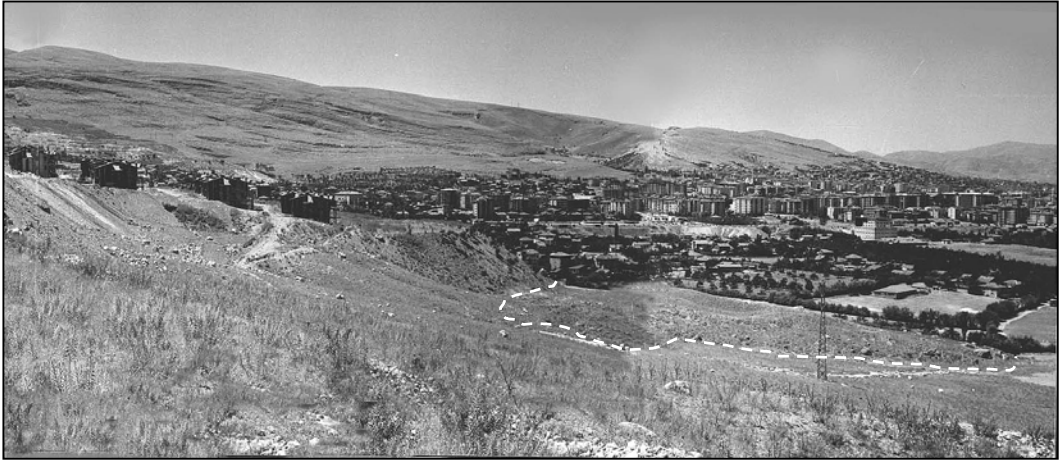
Foto 4: Yıkıkhane tepesi batı yamacında daha önce meydana gelen bir heyelanın enkazı (1) geride kilaşından oluşan tesviye dolguları (2) üzerine inşa edilen konutlar görülmektedir. Bu konutların zeminlerinde çökme ve kaymaya bağlı bozulmalar meydana gelmiştir. Daha geride Malatya şehrinin Elazığ yolu boyunca gelişen kısımları görülmektedir.
