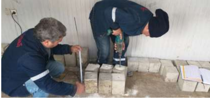
Resim 3.3 Betonlara ankraj deliği açılması
