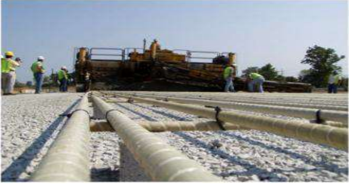
Resim 1.1 West Virginia eyaletinde GFRP donatılı bir yol yapımı (İnt. Kyn.1).
