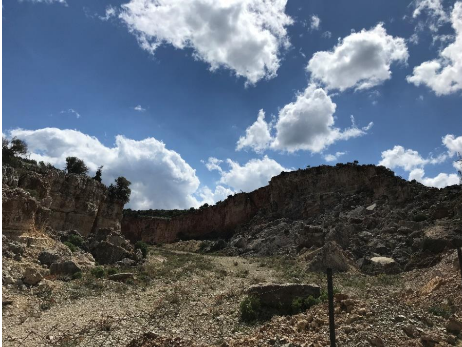
Şekil 102. Bağyaka Kömür Yatağında Meydana Gelen Kaya Göçmeleri
