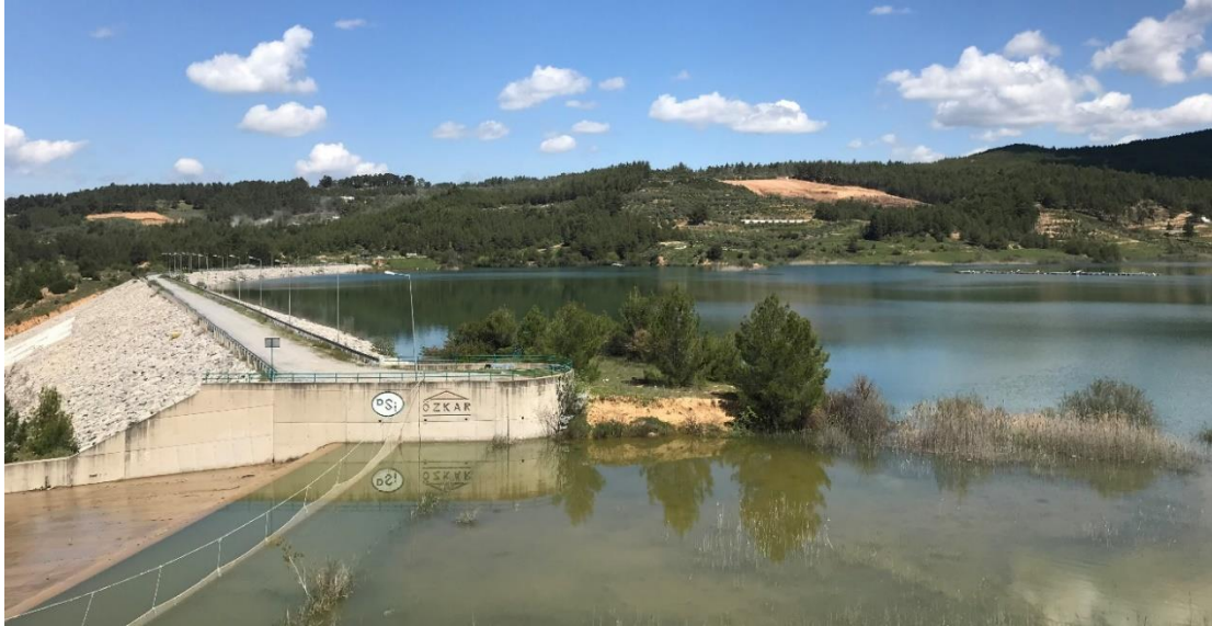
Şekil 34. Sırainler Deresi Üzerinde Sulama Amacıyla Yapılan Bayır Baraj Gölü
