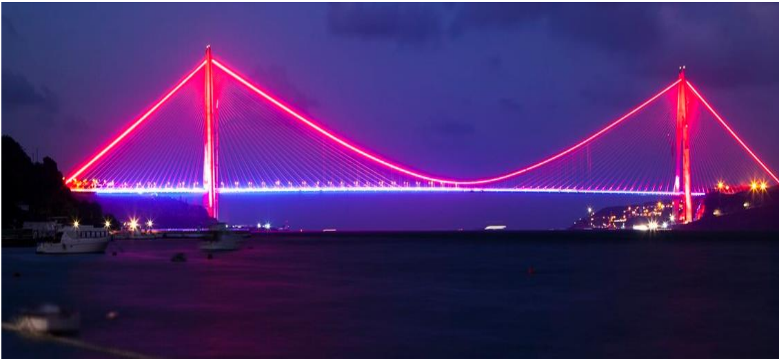
Resim 2. 5 Dış aydınlatmaya örnek bir köprü görüntüsü.
