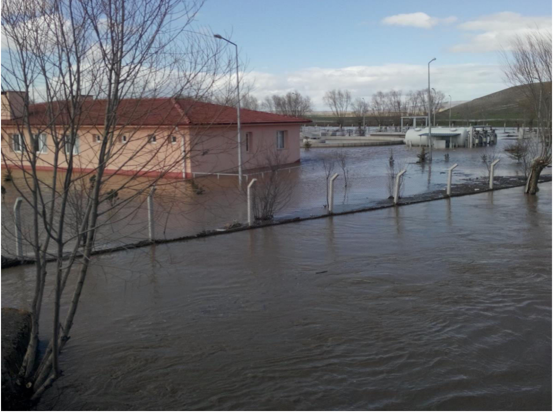
Resim 3.3 Taşkın sonrası su arıtma tesisi.
