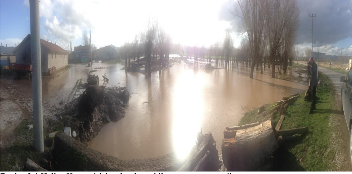
Resim 3.1 Hallaç Köyü girişi taşkından etkilenen yapı ve araziler.
