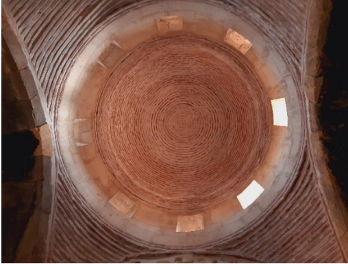
Resim 195. Sâhib Ata (İshaklı) Kervansarayı'nın Orta Bölümünde Bulunan Kubbeli Bölüm
