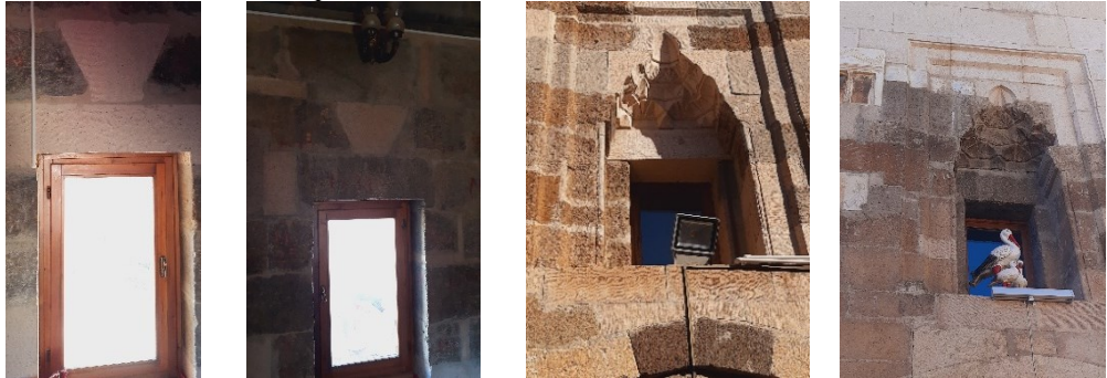
Resim 190. Sâhib Ata (İshaklı) Kervansarayı'nın Avlusunda Bulunan Köşk Mescidin Doğu ve Batı Cephelerinde Bulunan Pencereleri
