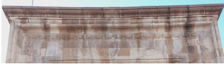
Resim 219. Sâhib Ata (İshaklı) Kervansarayı'nın Avluya Girişinde Bulunan Taç Kapıdaki Korniş ve Silmeler
