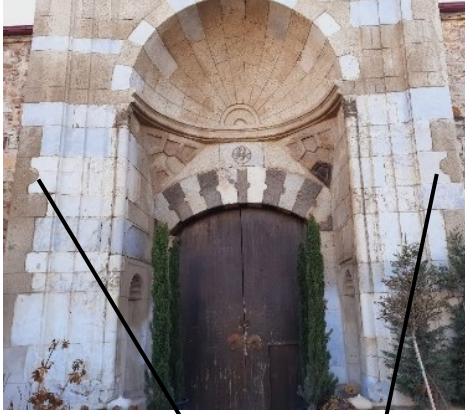
Resim 83. Çay Ebu'l-Mücahit Yusuf Kervansarayı'nın Taç Kapısında Bulunan Geçmeli Taşlar
