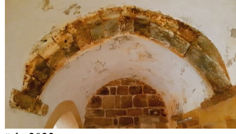
Resim 16. Anıtkaya (Eğret) Kervansarayı'ndaki Taştan Yapılmış Kemerlerden Bir Örnek
