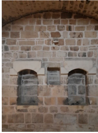
Resim 116. Döğەر Kervansarayı'nın Birinci Katındaki Ocaklardan Bir Görünüm, Ocakların Ortasında Dolap Boşluğu
