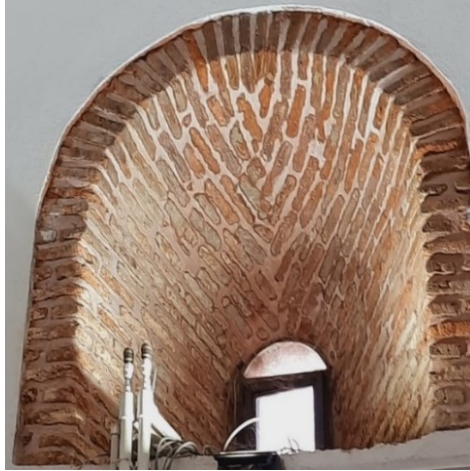
Resim 57. Çay Ebu'l-Mücahit Yusuf Kervansarayı'nın Mazgal Pencerelerinden Bir Örnek
