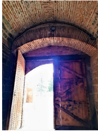
Resim 114. Döğer Kervansarayı'nın Birinci Katındaki Giriş Kapısının Tuğladan Yapılmış Kemerini
