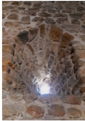
Resim 198. Sâhib Ata (İshaklı) Kervansarayı'nda Bulunan Mazgal Pencere 2
