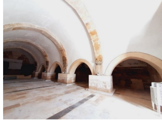
Resim 17. Anıtkaya (Eğret) Kervansarayı'ndaki Doğu-Batı Yönünde Uzanan Kısa Sivri Kemerler
