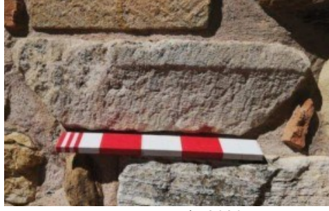
Resim 31. Kütahya Kalesi'ndeki Burçlar Arasında Görülen İmpost
