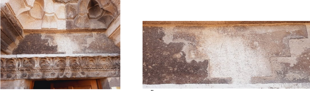
Resim 188. Sâhib Ata (İshaklı) Kervansarayı'nın Avlusunda Bulunan Köşk Mescidin Kapısının Üzerindeki Geçmeli Taşlar (Mescit Kapısı Girişi)
