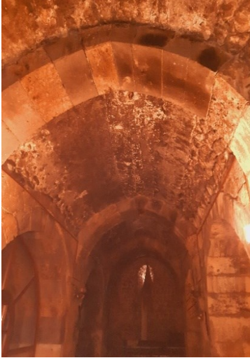
Resim 201. Sâhib Ata (İshaklı) Kervansarayı'nın Kapalı Kısımında Bulunan Bölümlerden Örnekler 1
