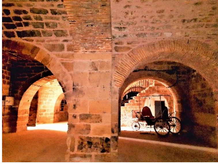
Resim 112. Döğer Kervansarayı'nın Birinci Katındaki Yan Yana Taştan ve Tuğladan Yapılmış Basık Kemerlerden Örnekler
