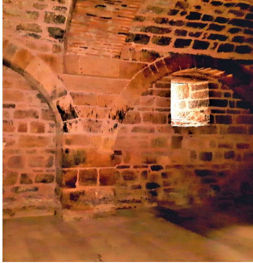
Resim 107. Döğer Kervansarayı'nın Birinci Katındaki Duvara Bitişik Vaziyetteki Ayaklardan Bir Örnek
