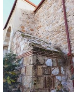
Resim 49. Çay Ebu'l-Mücahit Yusuf Kervansarayı'nın Taç Kapısının Sağ ve Sol Payandaları
