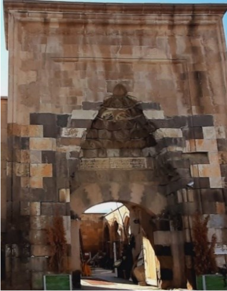
Resim 176. Sâhib Ata (İshaklı) Kervansarayı'nın Avluya Girişteki Taç Kapısında Bulunan Kapı Kemerini, Kilit Taşı ve Kapı Kemerinin Üzerindeki Birbirine Geçmeli Yarım Yuvarlak Planlı Taş Örgüsü
