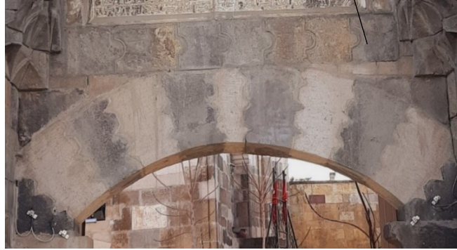
Resim 176. Sâhib Ata (İshaklı) Kervansarayı'nın Avluya Girişteki Taç Kapısında Bulunan Kapı Kemerini, Kilit Taşı ve Kapı Kemerinin Üzerindeki Birbirine Geçmeli Yarım Yuvarlak Planlı Taş Örgüsü
