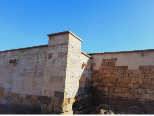
Resim 171. Sâhib Ata (İshaklı) Kervansarayı'nın Köşe Destek Kuleleri
