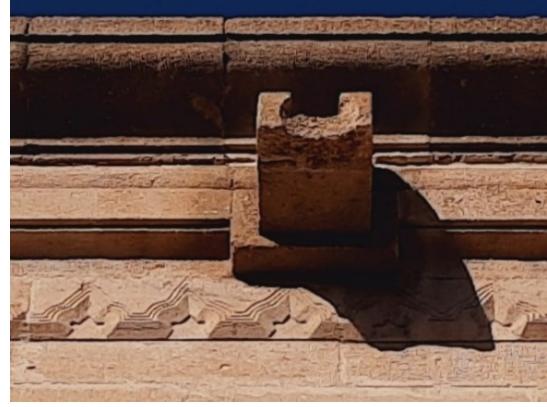
Resim 175. Sâhib Ata (İshaklı) Kervansarayı'nın Köşk Mescidinin Duvarında Bulunan Çörten (Detay)
