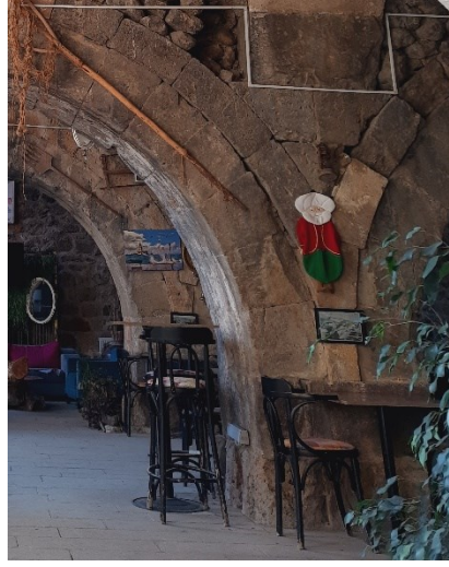
Resim 210. Sâhib Ata (İshaklı) Kervansarayı'nın Avlusunda Bulunan Sağ Taraftaki Revaklı Bölümdeki Ayaklar (İçerden Görünümü)
