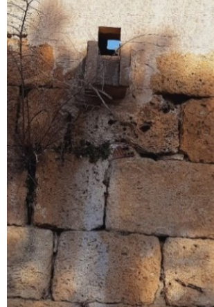
Resim 173. Sâhib Ata (İshaklı) Kervansarayı'nın Duvarlarında Bulunan Çörtenler
