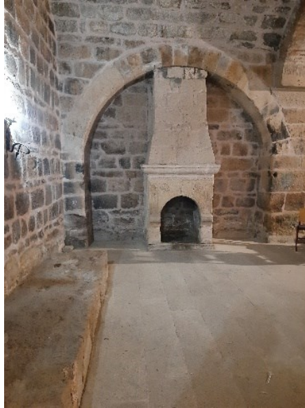
Resim 118. Döğەر Kervansarayı'nın Birinci Katında Bulunan Farklı Yapıdaki Ocak ve Ocağın Yanında Bulunan Hafif Yüksek Seki (Çıkıntı)
