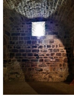
Resim 110. Döğer Kervansarayın Birinci Katındaki Mazgal Pencere, Farklı Cephelerdeki Pencere 2
