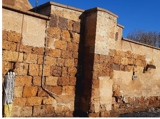
Resim 172. Sâhib Ata (İshaklı) Kervansarayı'nın Destek Kulesi (Detay)
