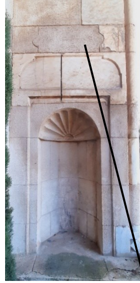
Resim 87. Çay Ebu'l-Mücahit Yusuf Kervansarayı'nın Taç Kapısında Bulunan Mihrabiye Üzerlerindeki Geçmeli Taşlar-Detay 2
