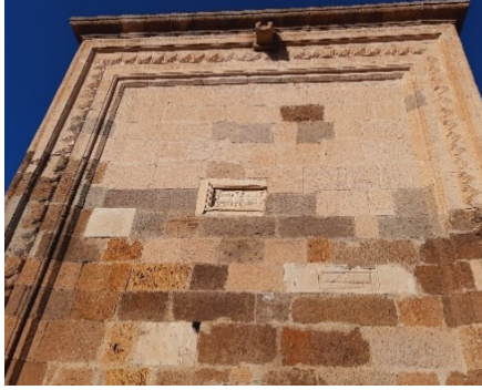
Resim 183. Sâhib Ata (İshaklı) Kervansarayı'nın Avlusunda Bulunan Köşk Mescidin Kible Duvarında Bulunan Devşirme Malzemeler
