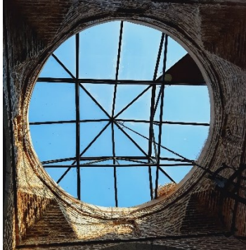
Resim 91. Çay Ebu'l-Mücahit Yusuf Kervansarayı'nın Kapalı Kısımdaki Aydınlık Fenerinde Bulunan Pencere Boşlukları
