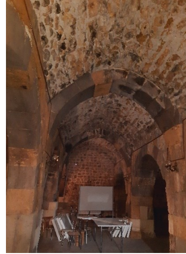
Resim 203. Sâhib Ata (İshaklı) Kervansarayı'nın Kapalı Kısımında Bulunan Bölümlerden Örnekler 3
