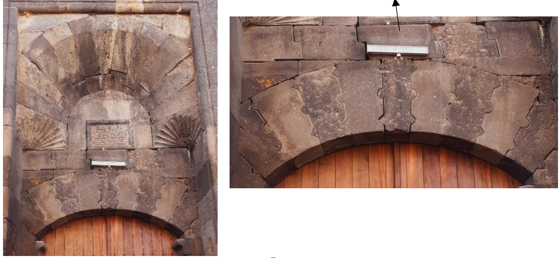
Resim 194. Sâhib Ata (İshaklı)Kervansarayı'nın Kapalı Kısmın Taç Kapısında Bulunan Kapı Kemerli, Kilit Taşı ve Kapı Kemerinin Üzerindeki Z Planlı Geçmeli Taş Örgüsü
