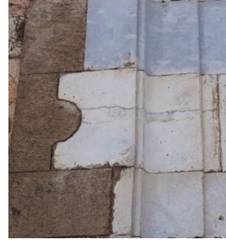
Resim 85. Çay Ebu'l-Mücahit Yusuf Kervansarayı'nın Taç Kapısının Solunda Bulunan Geçmeli Taşlar (Detay)
