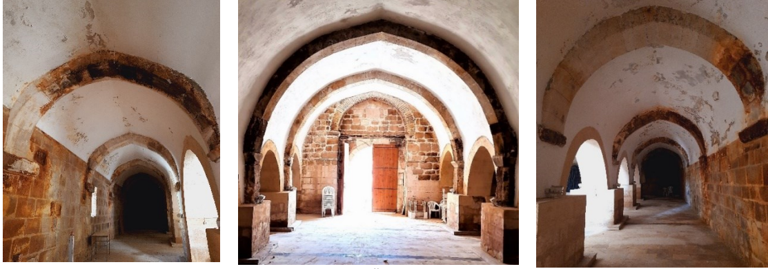
Resim 13. Anıtkaya (Eğret) Kervansarayı'ndaki Üst Örtüyü Taşıyan Sivri Kemerleri
