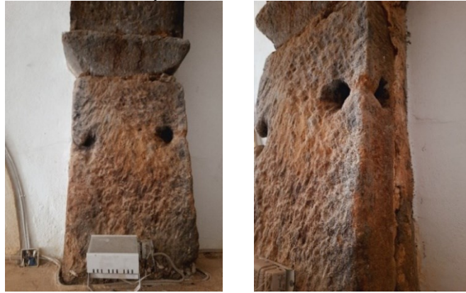
Resim 14. Anıtkaya (Eğret) Kervansarayı'nın Kemer Başlangıçlarındaki Hayvan Bağlamak İçin Kullanılan Delikler
