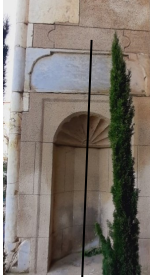
Resim 86. Çay Ebu'l-Mücahit Yusuf Kervansarayı'nın Taç Kapısında Bulunan Mihrabiye Üzerlerindeki Geçmeli Taşlar- Detay 1
