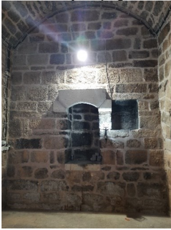
Resim 115. Döğەر, Kervansarayı'nın Birinci Katındaki Ocaklardan Bir Görünüm, Ocağın Sağında Dolap Boşluğu
