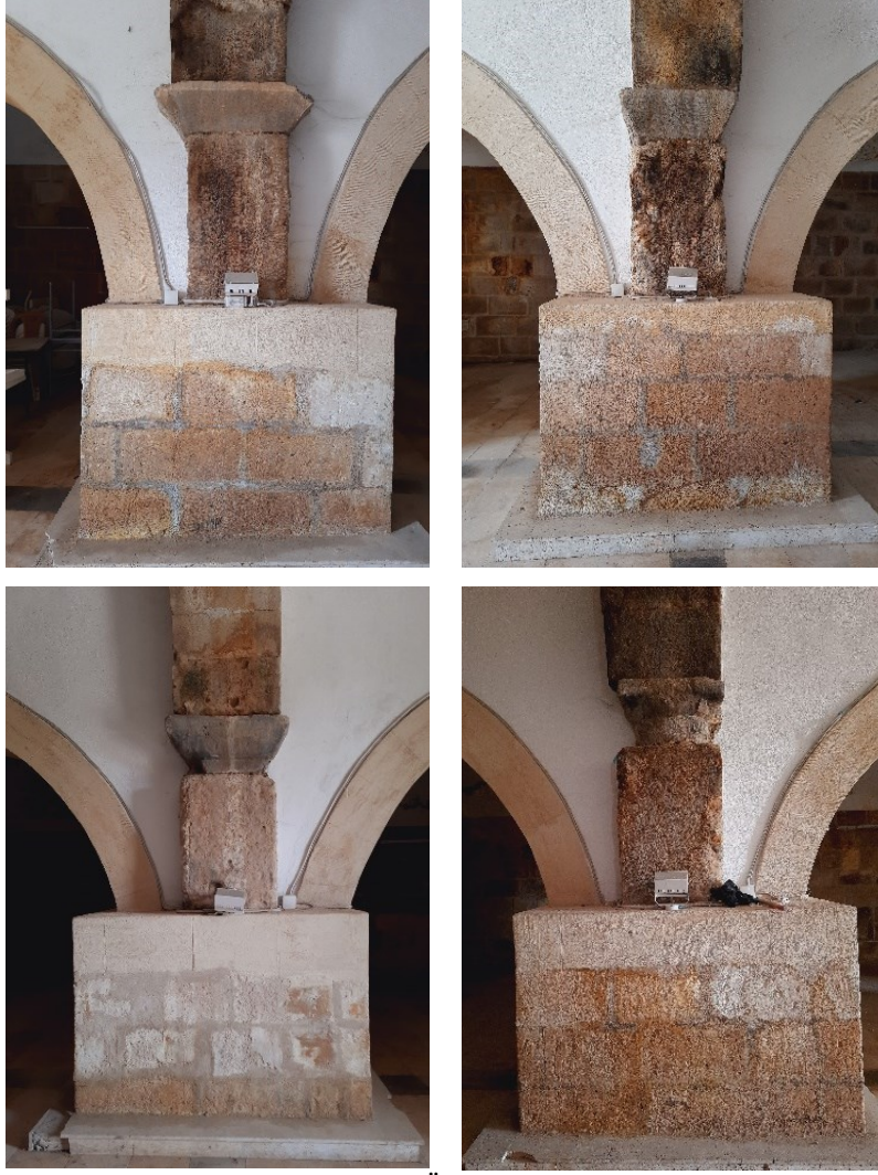
Resim 12. Anıtkaya (Eğret) Kervansarayı'ndaki Ayaklardan Örnekler
