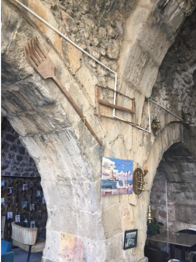
Resim 207. Sâhib Ata (İshaklı) Kervansarayı'nın Avlusunda Bulunan Sağ Taraftaki Revaklı Bölümdeki İkişer Kemer Açıklığı
