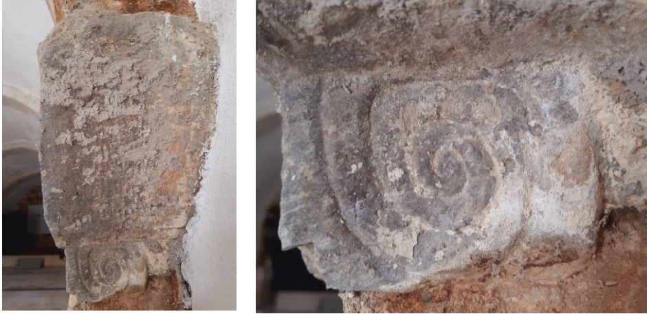
Resim 28. Anıtkaya (Eğret) Kervansarayı'nın Kemerlerinde Bulunan Devşirme Malzeme 1 (İon Sütun Başlığının Yan Yüzü, Ön Yüzü ve Süsleme Detayı)
