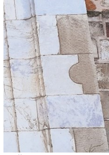
Resim 84. Çay Ebu'l-Mücahit Yusuf Kervansarayı'nın Taç Kapısının Sağında Bulunan Geçmeli Taşlar (Detay)
