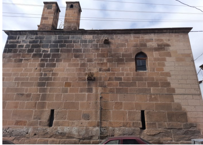
Resim 111. Döğer Kervansarayı'nın Sağ Tarafındaki (Doğu Cephesi) Mazgal Pencere Açıklığı
