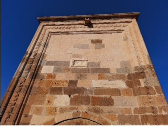
Resim 174. Sâhib Ata (İshaklı) Kervansarayı'nın Köşk Mescidinin Duvarında Bulunan Çörten
