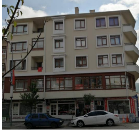
Şekil 4. 20 Nolu bina-bitmiş hali
