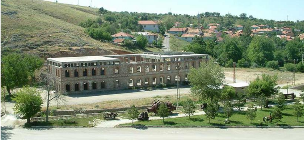
Şekil 139. Eski Deri Fabrikası.
