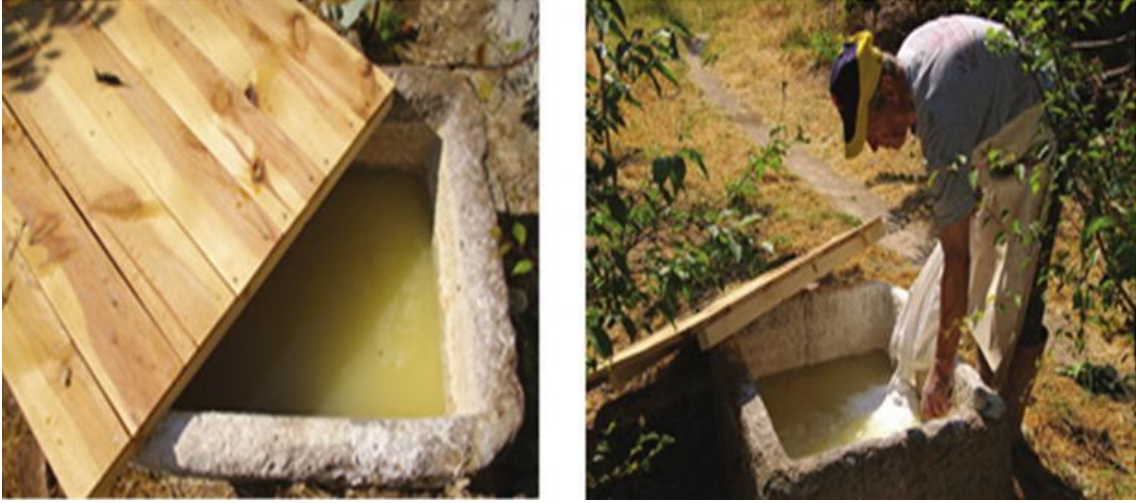
Şekil 6. Hazırlan Kireçlerin, Kireç Havuzlarında Karıştırılması.
