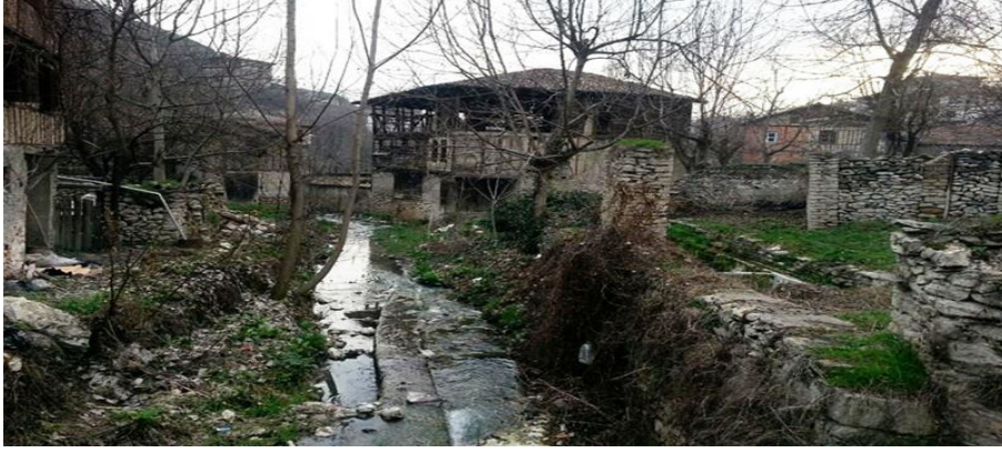
Şekil 2. Dere Kenarına İnşa Edilen Tabakhane.
