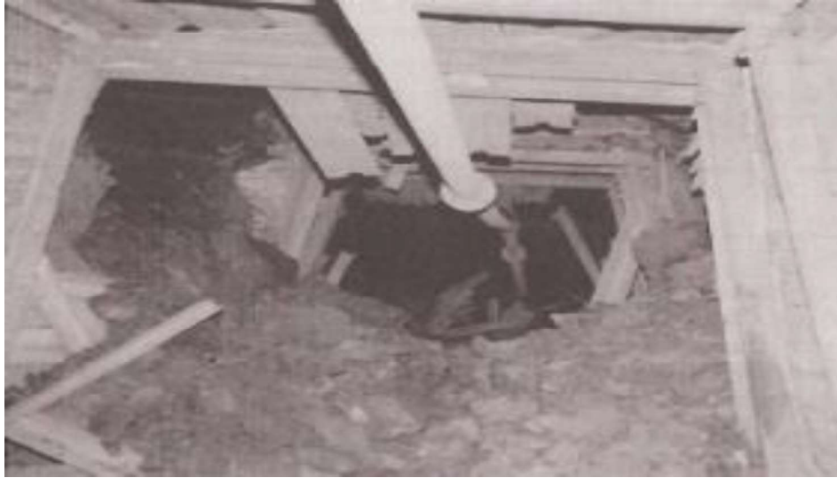
Şekil 3. Maden Kazalarında İkinci Sırada Olan Bir Göçük Olayı Sonrası Maden Ocağının Görünüşü
