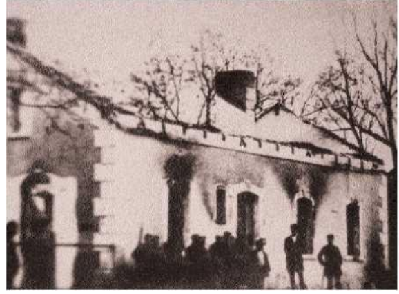
Yunanlılar Tarafından Yakılan İstasyon Binası
