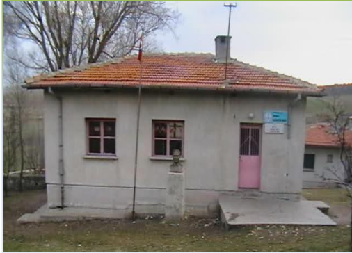
Foto 5. Bayat İlçesinde Birleştirilmiş Okullardan Birisinin Görünümü (İnpınar Köyü).
