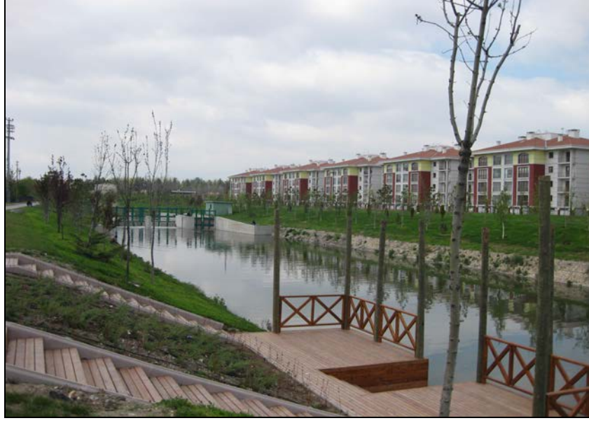
Foto 4.3. Tepebaşı Belediyesi'nin Porsuk Çayı'nın hemen kenarına yapmış olduğu Kentpark konutları (Fotoğrafın sol tarafında Porsuk Çayı çevresindeki dinlenme alanları bulunmaktadır) .
