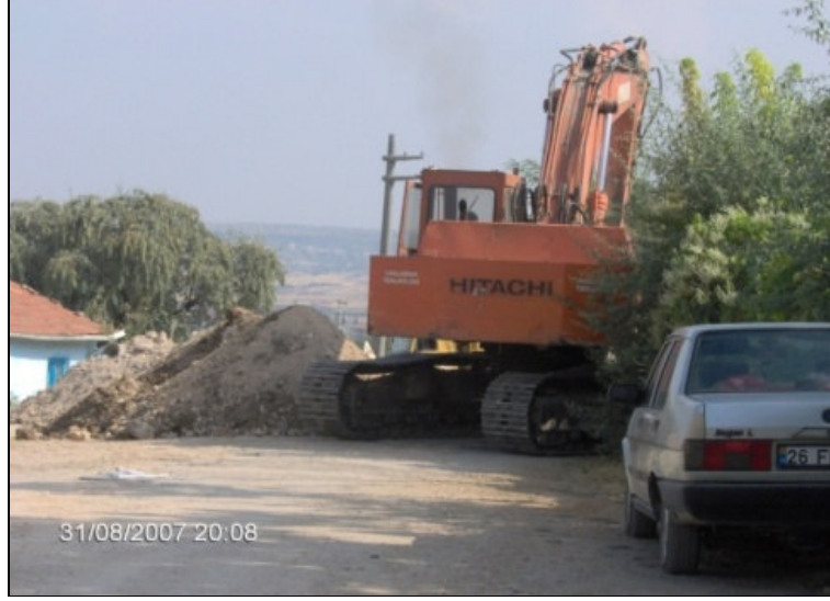
Foto 5.3. Eskişehir’de yapılan yol çalışmaları
