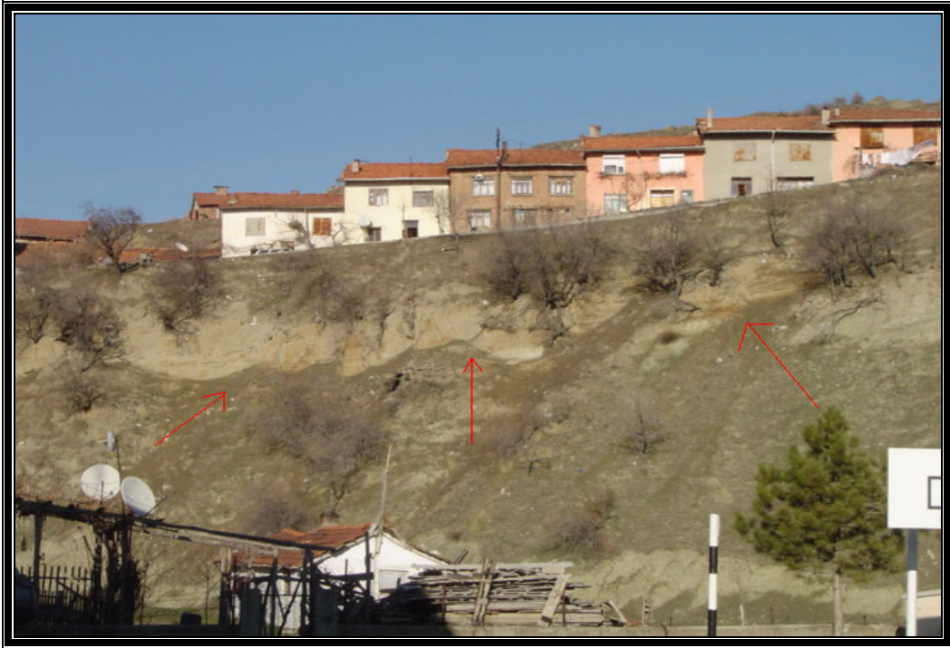
Foto 8. Hisar Mahallesinde Eğimli Arazilerde Görülen Toprak Kayması.
