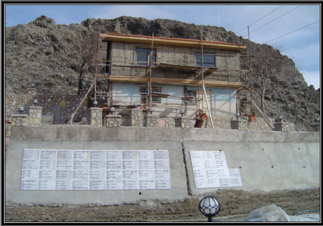
Foto 35. İnşaat Halindeki Deprem Anıt Alanından Bir Görünüm.
