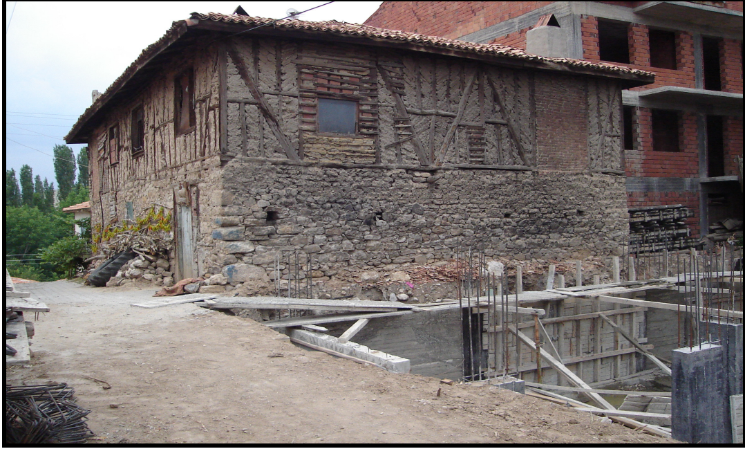
Fotoğraf 13. Kasaba İçindeki Eski Yerleşim Yerindeki Evlerin Yerine Yapılan Yeni Konutlardan Bir Görünüm
