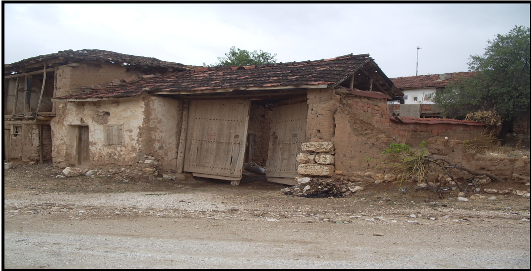
Fotoğraf 17: Eski Meskenlerde Giriş Kapısı (Kocakapı-Alfaklar Köyü).
