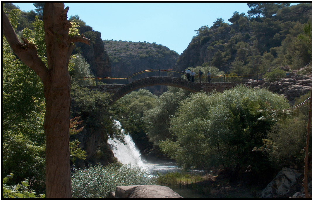
Fotoğraf 6: Banaz Çayı ve Santralden Gelen Suyun Clandras Köprüsünün Batısında Şelale Yaparak Dökülmesi.
