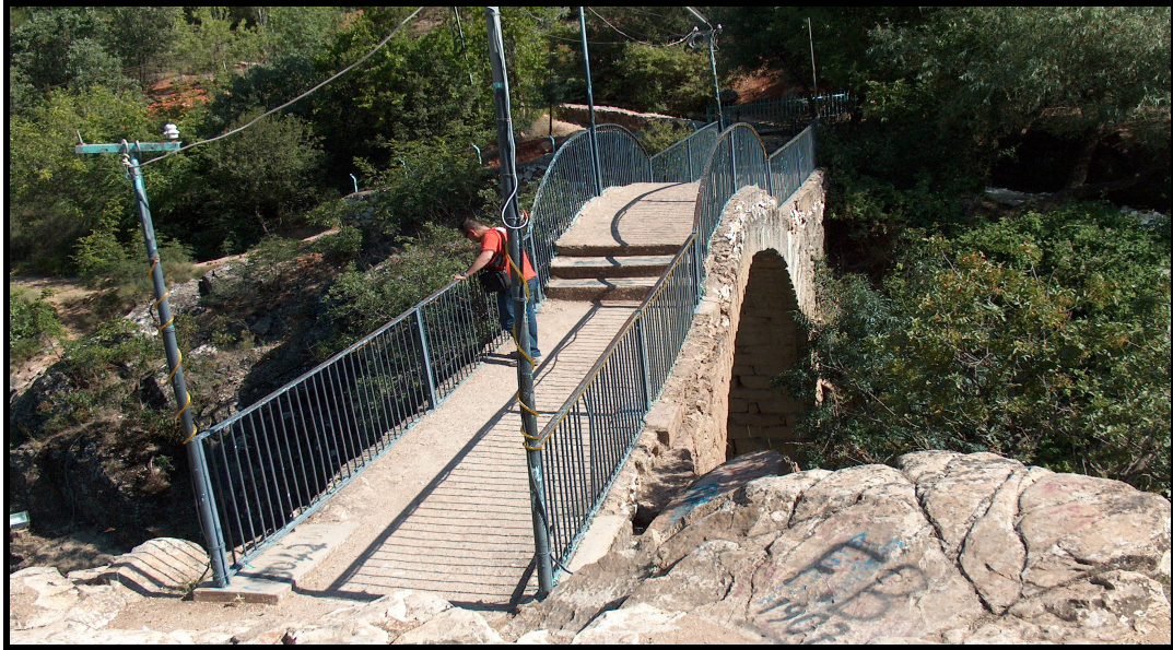
Fotoğraf 41: Karahallı'da Clandıras Köprüsünden Bir Görünüş.
