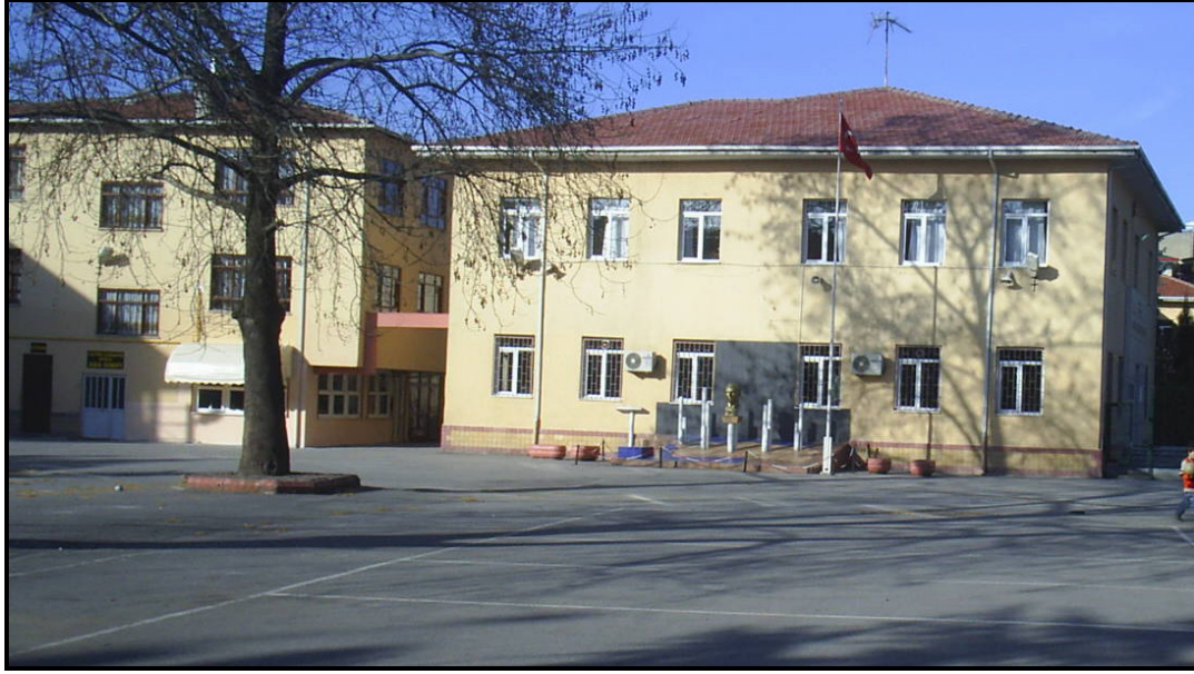
Resim 5. Deprem Sonrasında Yıkılan Atatürk İlköğretim Okulunun Yeni Hali.
