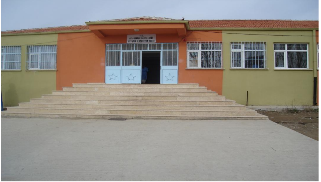
Fotoğraf 6. Akharım İlköğretim Okulu'ndan Bir Görünüm
