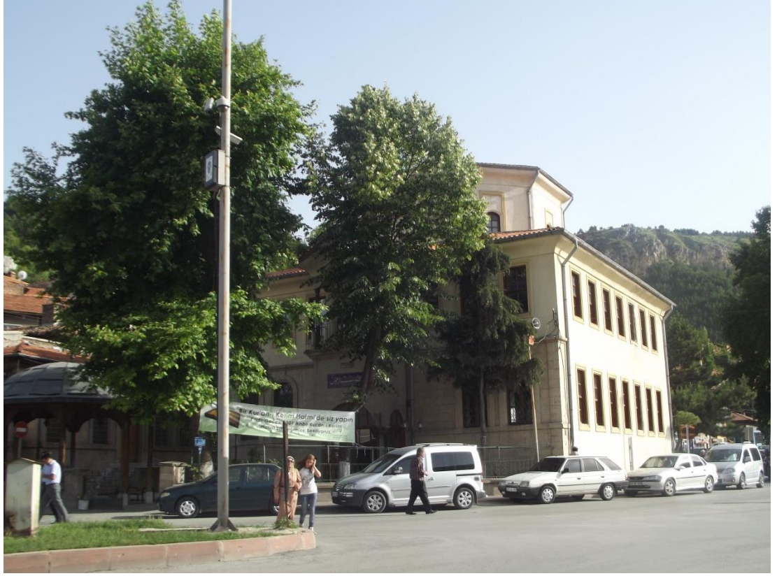
Ek 20. Kütahya Mevlevihânesi ve adli davaya konu olduđunu düşünđüğümüz pencereleli duvar.
