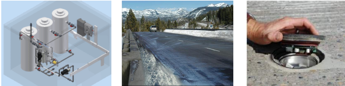
Resim 2.2 Freeze Free® otomatik solüsyon püskürtme sistemleri (İnt.kyn.1)
