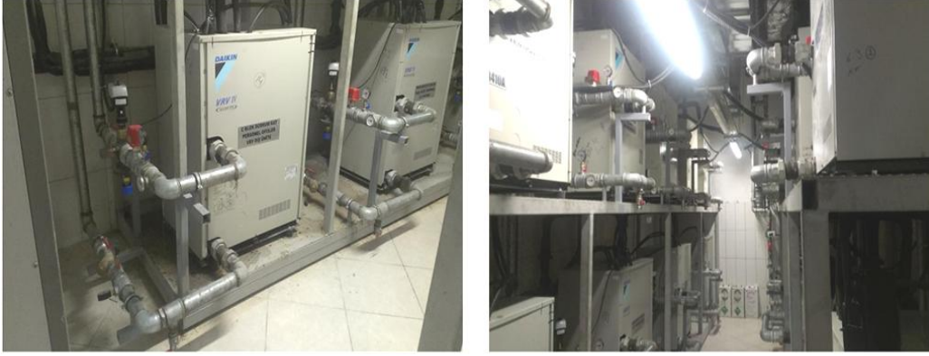
Şekil 2.28 Su soğutmalı dış üniteli VRV/VRF sistemler.
