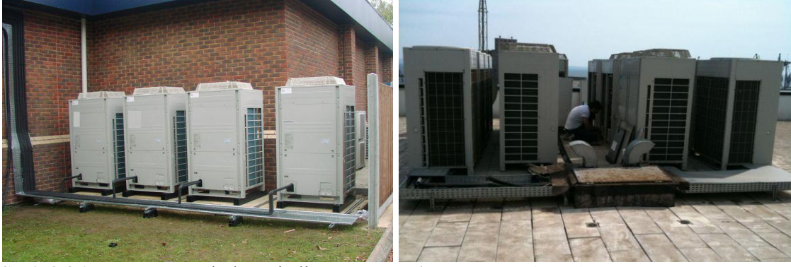
Şekil 2.26 Hava soğutmalı dış üniteli ısı pompası (VRV/VRF) sistemler.
