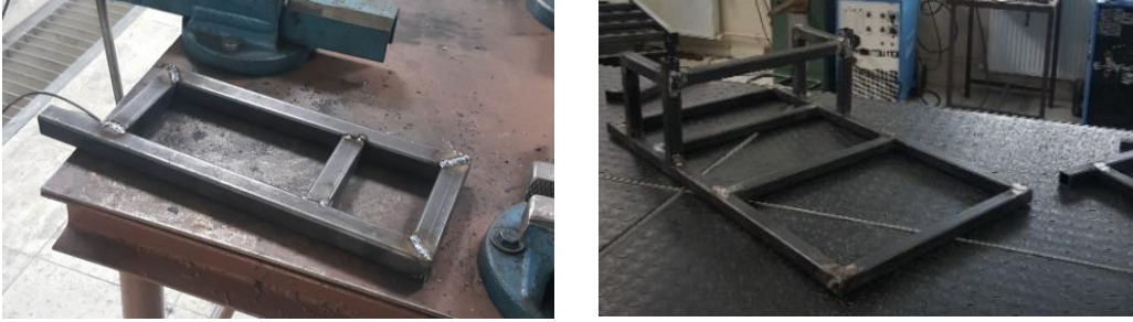
Şekil 4.24 KA şasi parçalarının imalatı.
